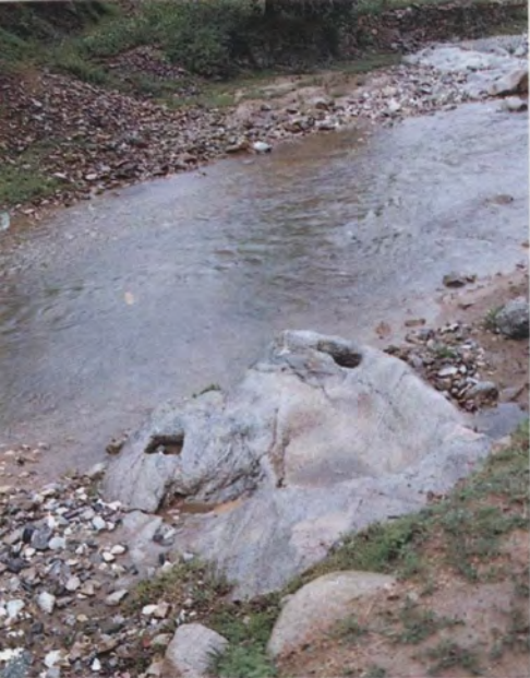
15 蓝田道上的“蓝桥”桥柱孔
