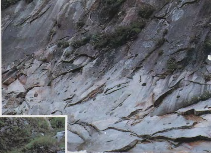
2 蓝桥水出口处的 武关道栈孔
