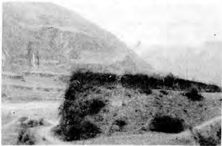
图2-4-3 甘泉县方家河乡“圣马桥”引桥遗迹
