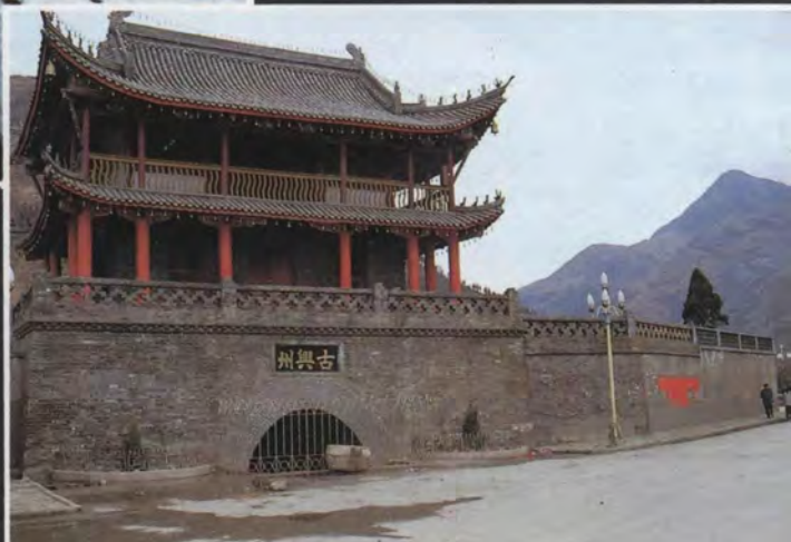
4 唐代兴州城楼今貌
