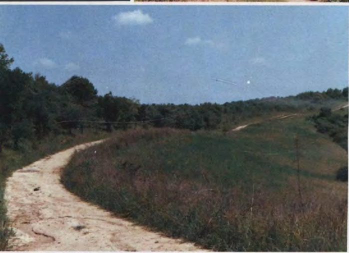
4 子午岭斜梁上的直道遗迹
