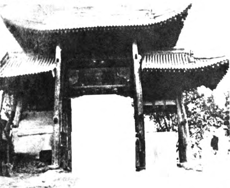
灞桥桥头之牌楼。
