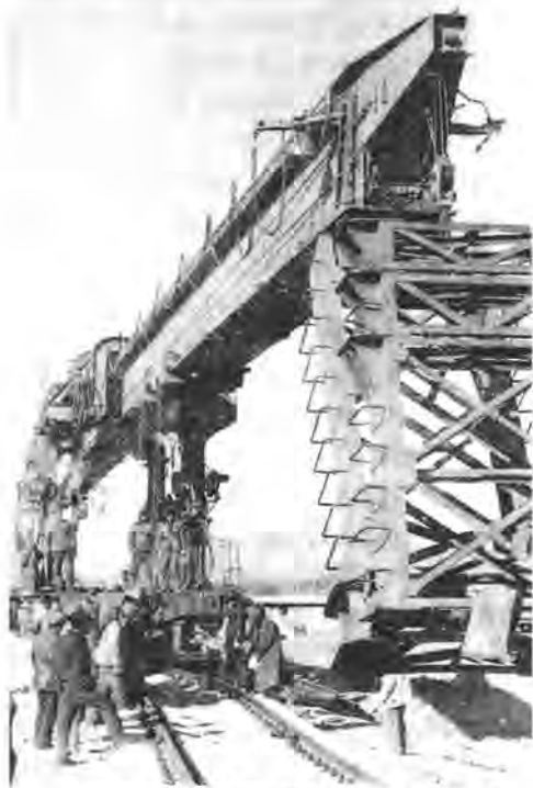
筑路工人冒严寒铺设神木至朔县铁轨
