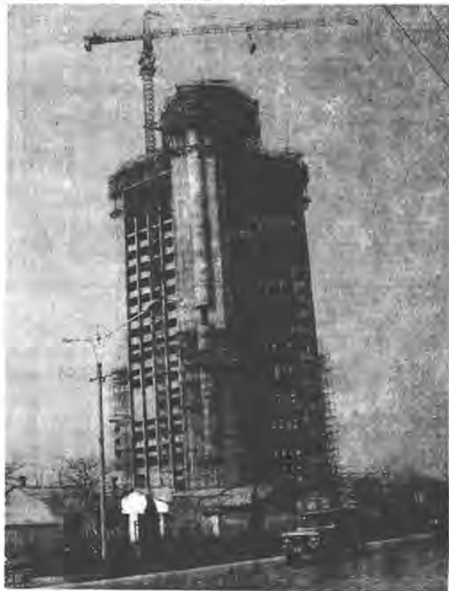
陕西省广播电视中心主体大楼 李书宽摄
