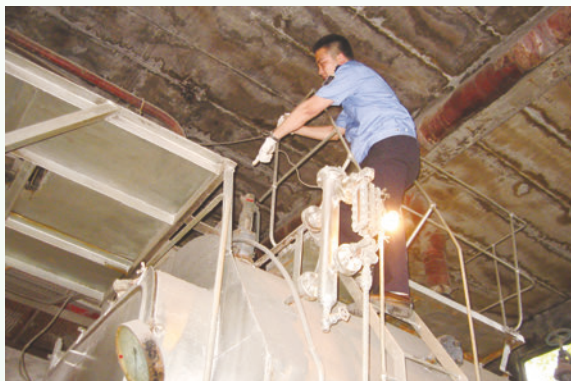
执法人员检查锅炉安全
