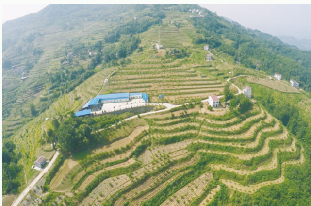
瀛天农林生态园畜禽养殖废水综合利用项目
