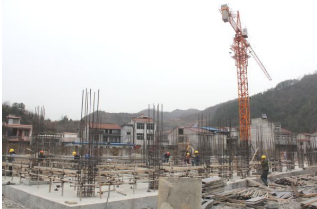
建设中的后田坝安置点
