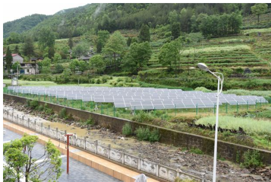
12月，建成庄房光伏电站
