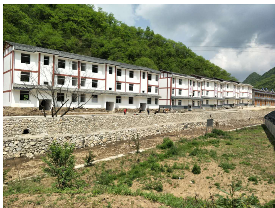
鲁家坝移民点
