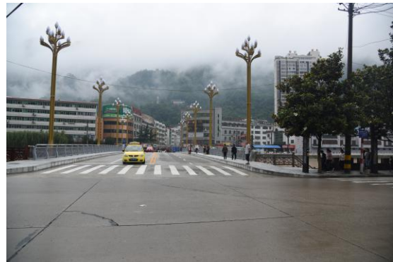
7月1日，改建的河滨路大桥
