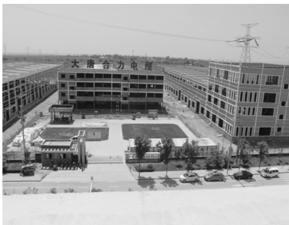
2017年度正在建设中的大唐合力电缆项目（李雪萍提供）
