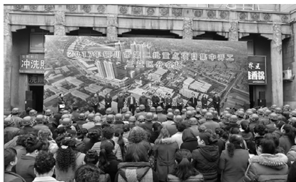
2017 年 3 月 22 日，王益区 12 个重点项目集中开工仪式在文化宫片区改造项目现场举行
