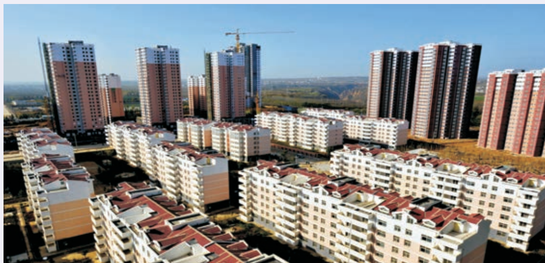
2017年，正在建设中的锦绣园保障房项目
