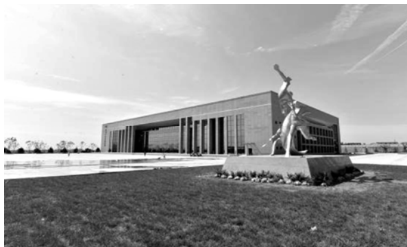
正在建设中的铜川市全民健身馆 （王小绒 提供）
