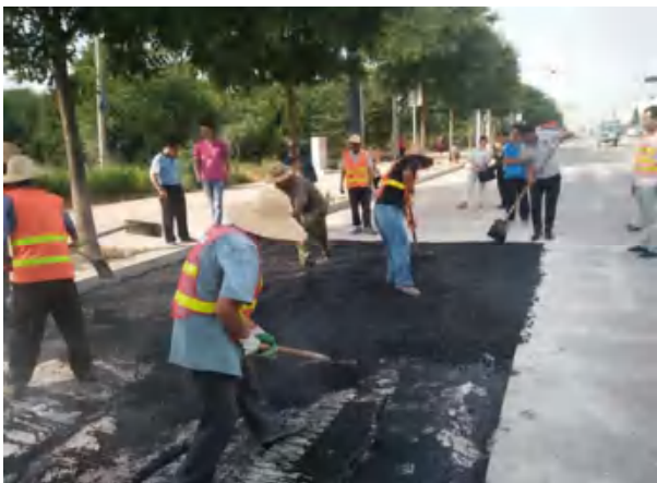
2018年铜川市破损路面修复工程(部分)
