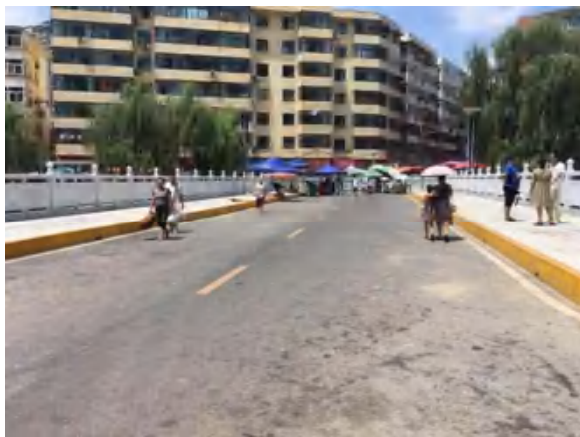
7 月 26 日，光明巷微循环道路改造工程完成，正式通车通行 (市城市管理执法局提供)
