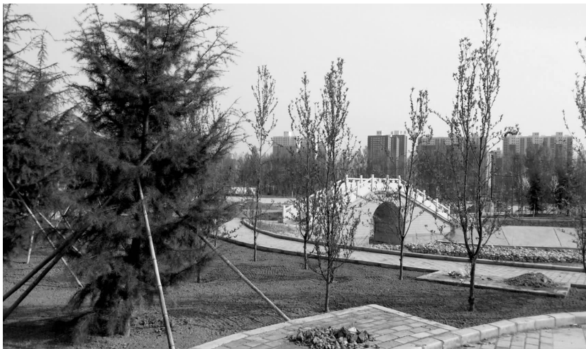
建设中的莽山水景公园
