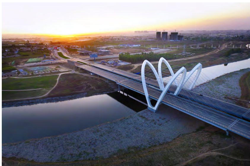
沔东新城富裕路沔河大桥
