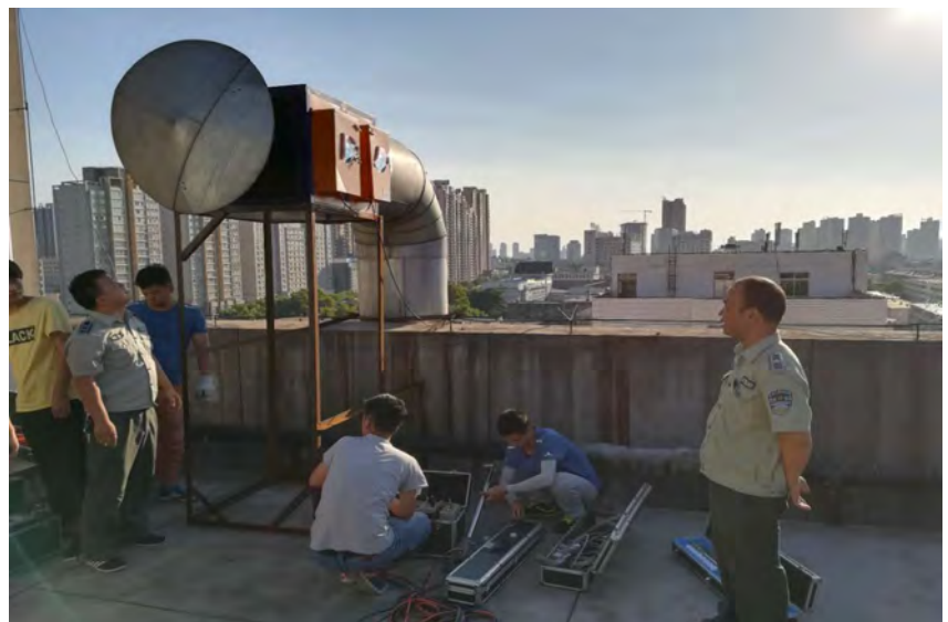
第三方监测机构对餐饮行业进行油烟检测 (市城市管理执法局 供)
