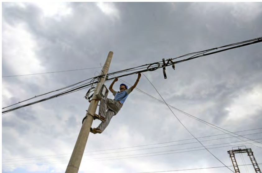
电信装维工程师为用户光网装机施工 (中国电信咸阳分公司 供)
