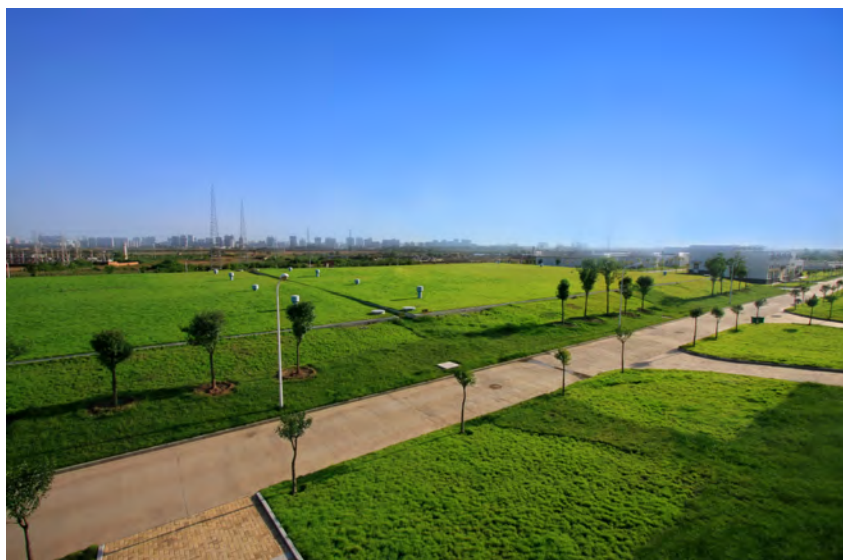
咸阳石头河净水有限公司清水池
