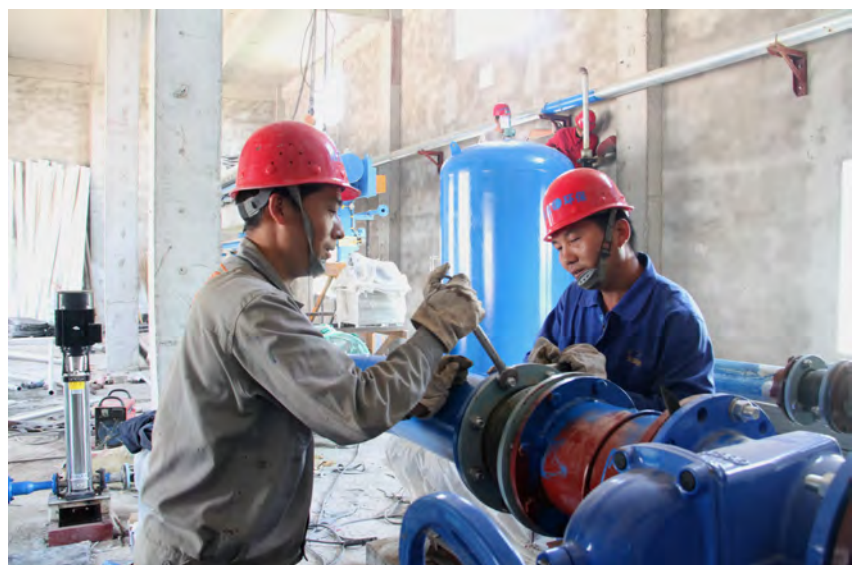
技术人员在旬邑县太村镇污水处理厂安装设备
