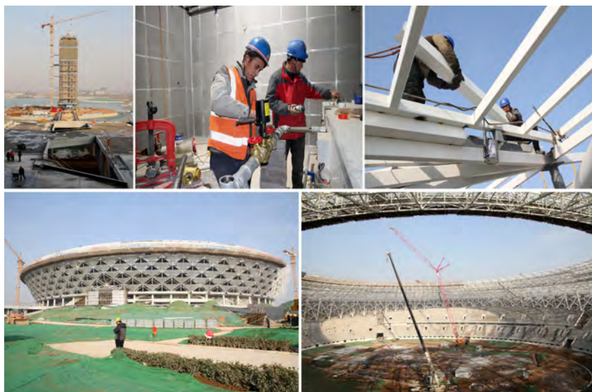
正在建设中的咸阳奥体中心
