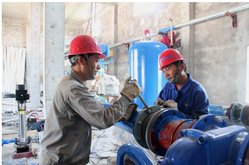
技术人员在污水处理厂安装设备
