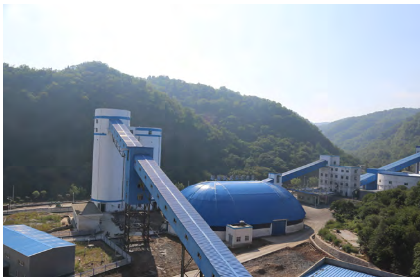
青岗坪煤矿环保型储煤场
