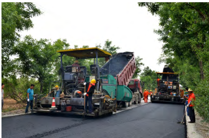
公路施工现场
