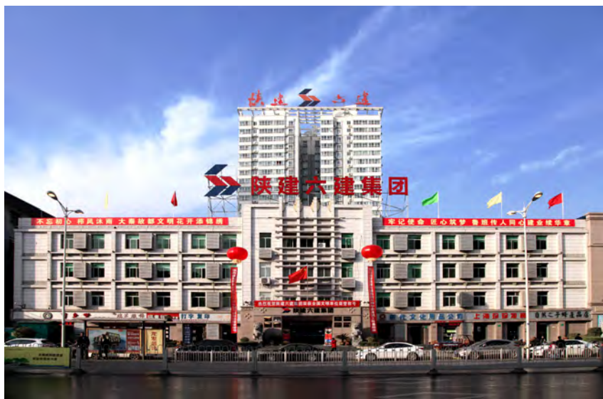
陕建六建集团办公楼
