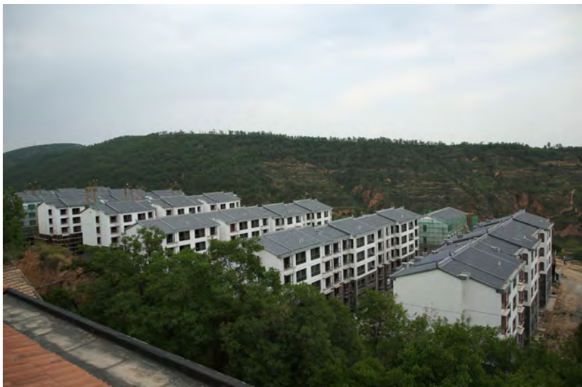
永寿县永平镇裕丰社区移民搬迁安置点
