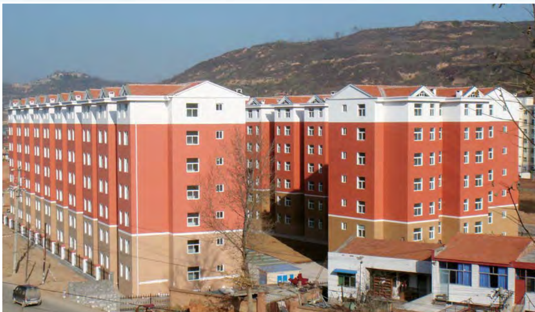
廉租住房项目——刘家沟惠民家园小区建成并投入使用。项目总投资2626万元，总建筑面积15448平方米，房屋308套
