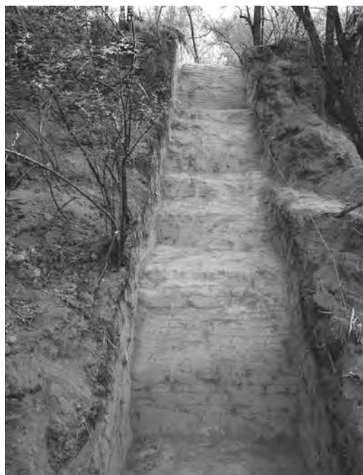
图四 直道盘山道的夯土护坡
