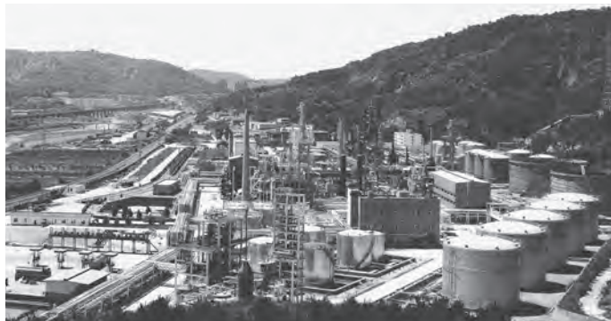
项目建设一角
