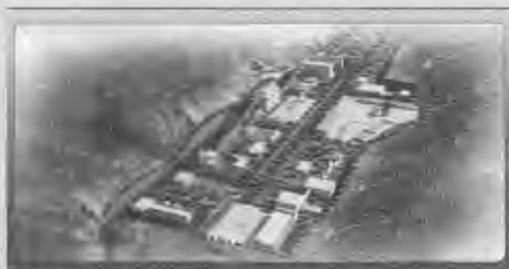
陕西富源煤业有限公司党家河煤矿鸟瞰图
