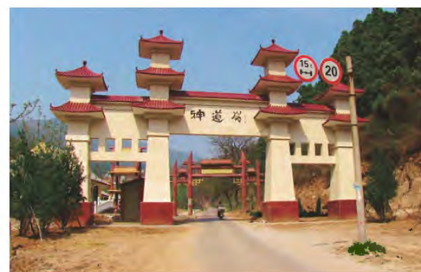
神道岭景区西大门景观提升工程
