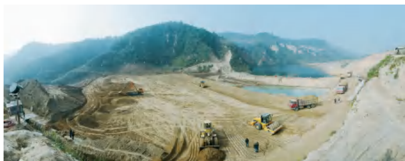
建设中的沙西沟大坝
