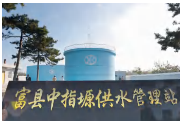
富县中指塬供水管理站
