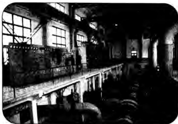
西干一级抽水站机房
