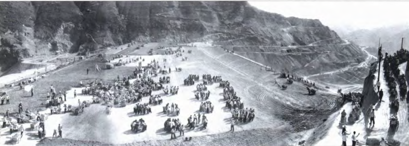
▲ 大坝回填碾压
