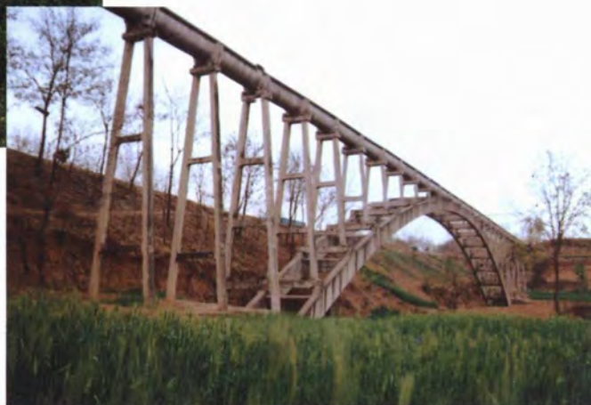
▲ 北三抽一支渠双桥渡槽
