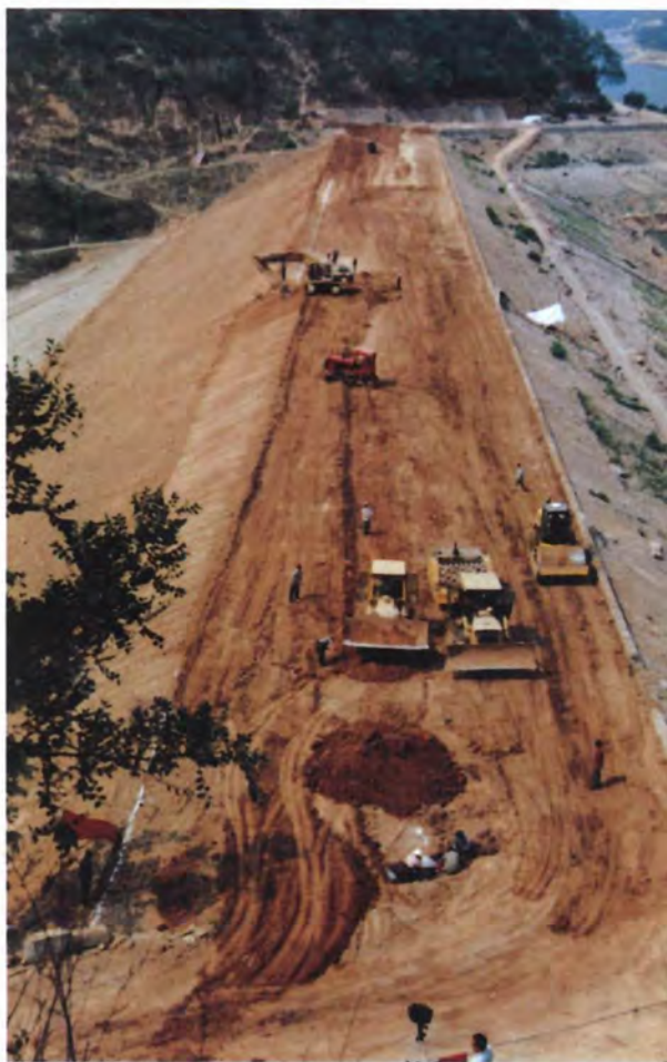
▲ 2003年6月，大坝加高培厚施工现场
