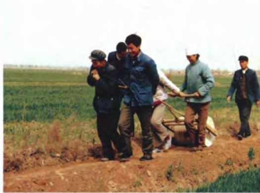
灌区配套施工中渠道土方碾压
