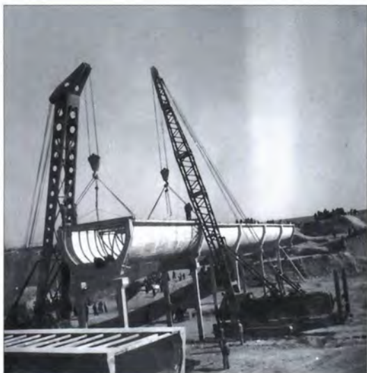
▲ 雍水河渡槽吊装
