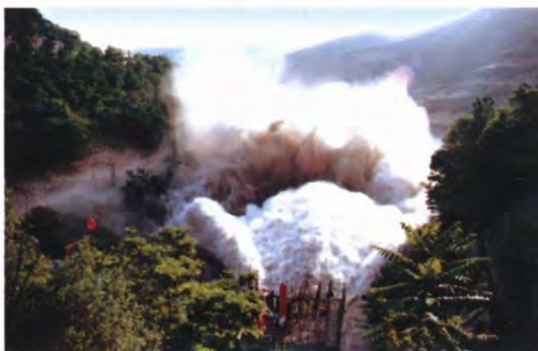
▲ 2002年5月，泄洪洞出口闸门改造后泄水试运行
