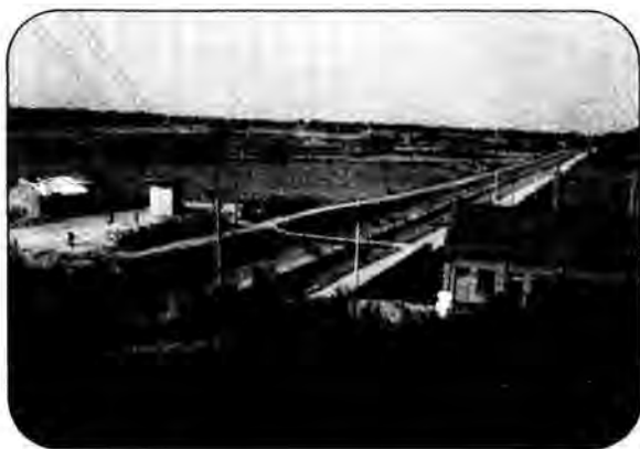
孔头沟渠库结合工程
