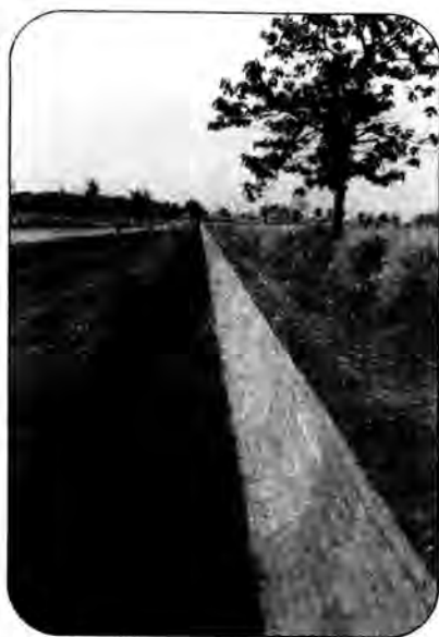
洞口抽水站支渠
