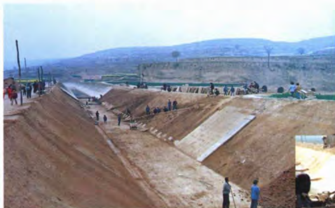
▲ 1995年，总干渠薛家沟填方渠段改造
