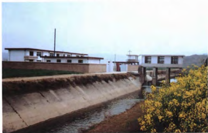
▼ 水库向宝鸡市区供水工程取水口
