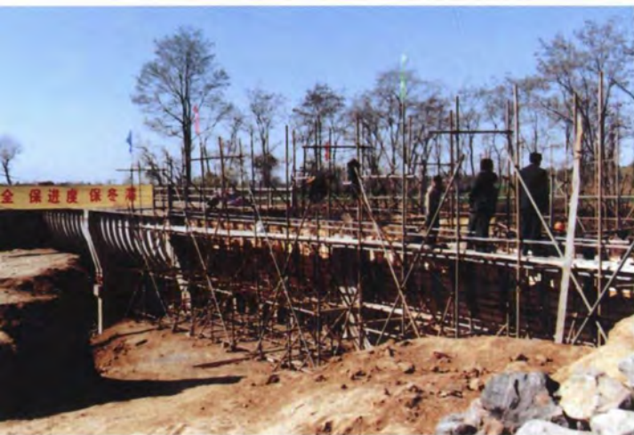
▲ 2002年秋，肖家桥渡槽修复改造
