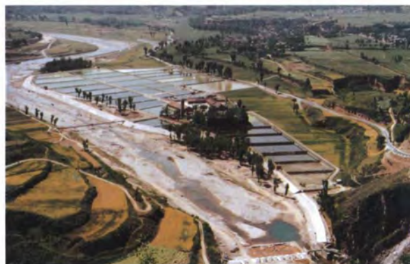
▲ 冯家山水库鱼场全貌
