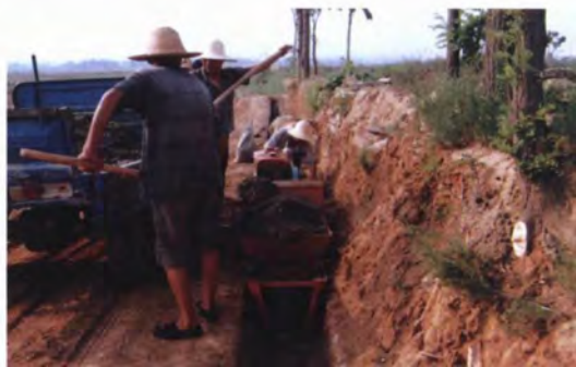
田间U形渠道机械衬砌施工
