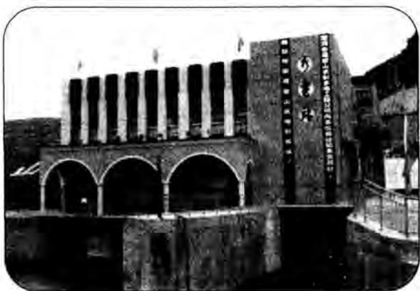
坝后一级电站外景
