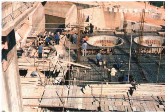
▲ 1991年，冯家山水利水电工程公司在坝后一级电站施工
