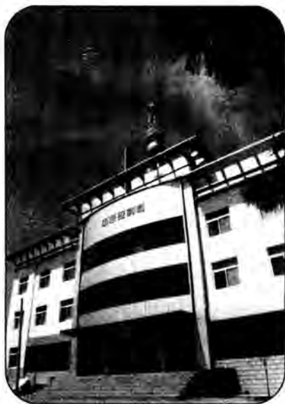
枢纽中心控制楼
