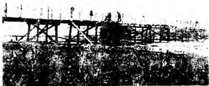
图 2-3-5 黄沙河桥施工
