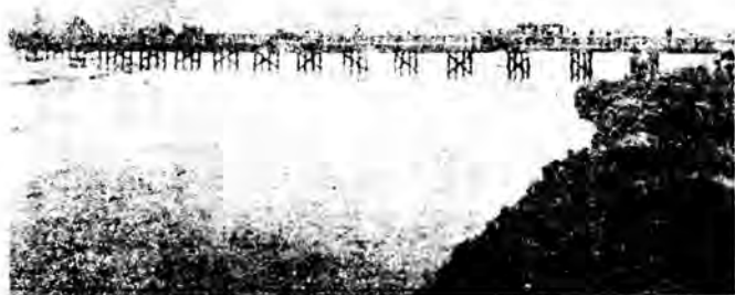
图 2-3-6 九洲河木架桥
