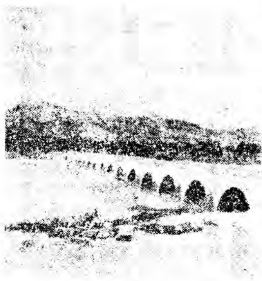
图2-4-3 绥德无定河石拱桥
