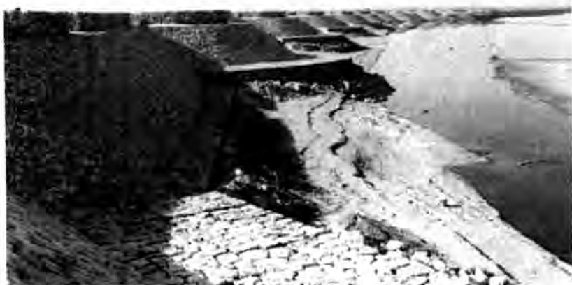
华县渭河北拾护岸工程
