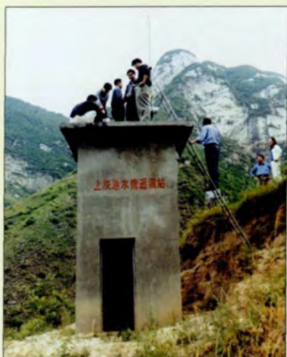
◆ 南山支流上灰池水情遥测站
