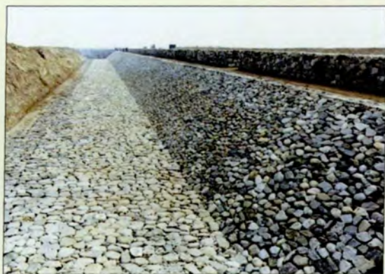
◆ 华县滨坝上延工程
