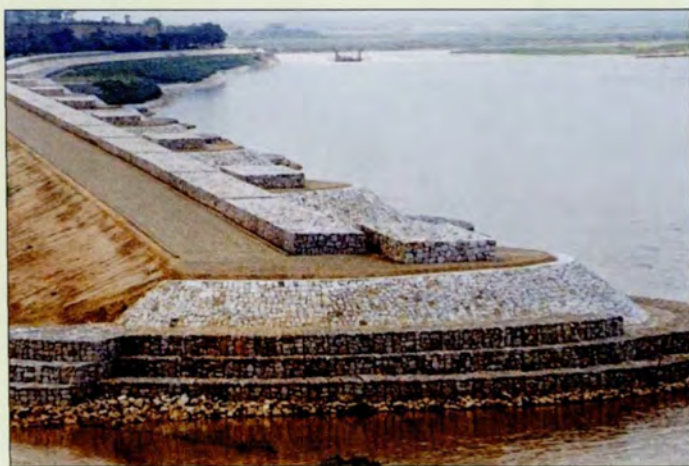
◆ 潼关渭河吊桥险工
