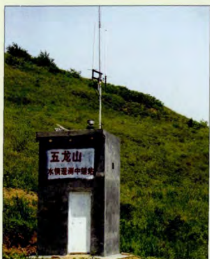
◆ 南山支流水情遥测中继站
