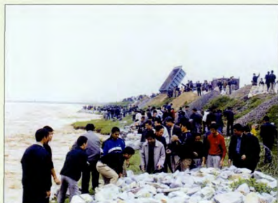
◆ 咸阳渭城区正阳工程抢险
