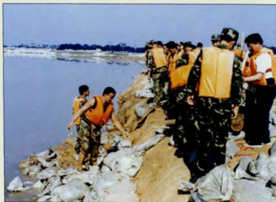
◆ 华阴移民围堤抢险
