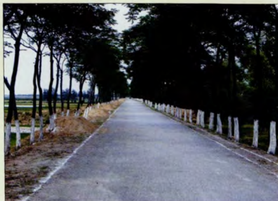
◆ 大荔渭河防护大堤
