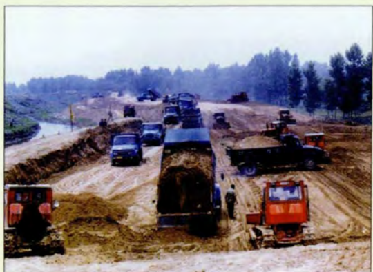
◆ 1998年5月罗纹河堤坡加固施工
