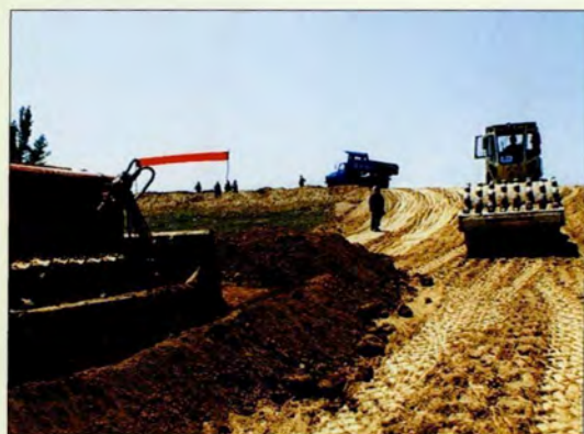
◆ 2001年临渭区苍渡护岸顺坝机械化施工
