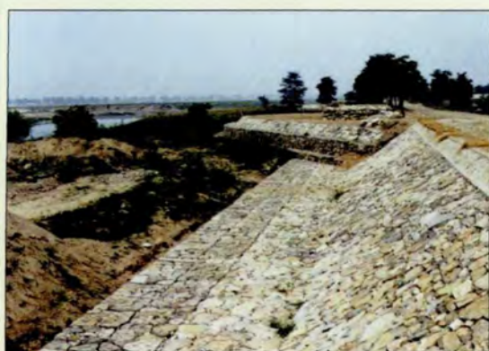
◆ 咸阳渔王险工
