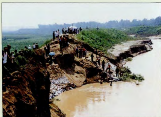
◆ 1996年8月南山支流决口封堵抢险
