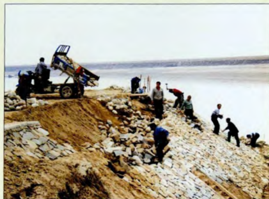
◆ 渭河险工坝垛砌护
