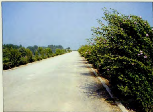
◆ 华县渭河防护大堤
