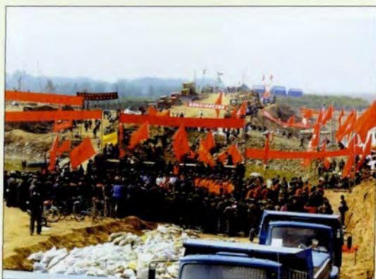
◆ 2003年9月12日石堤河口堵口胜利合龙
