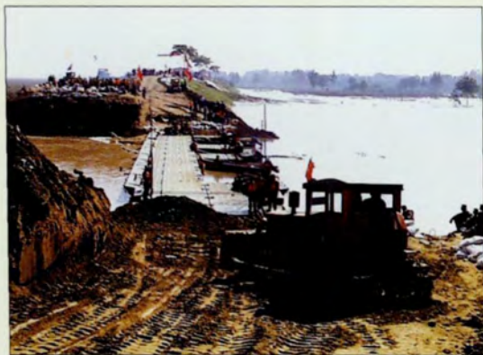
◆ 中国人民解放军舟桥团赶架石堤河口浮桥
