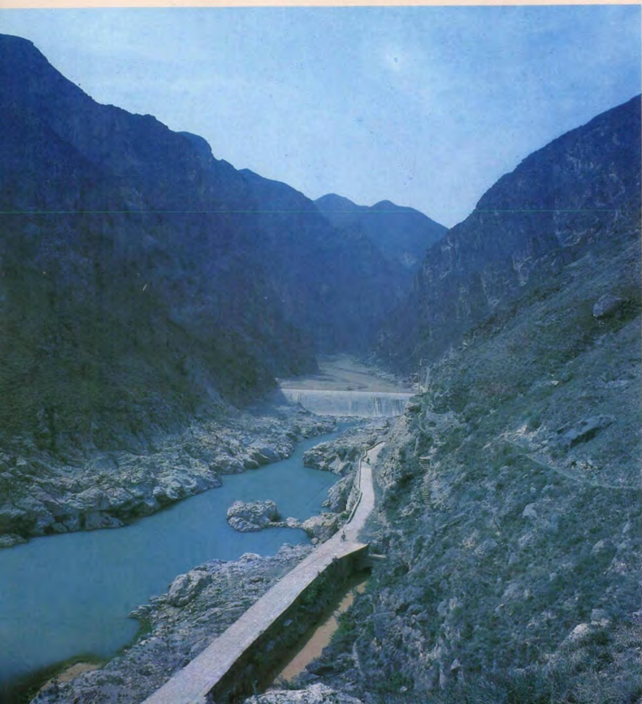
渠首枢纽工程
