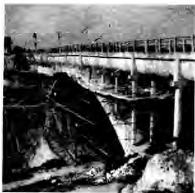
图5—2 堤浒渡槽加固施工
