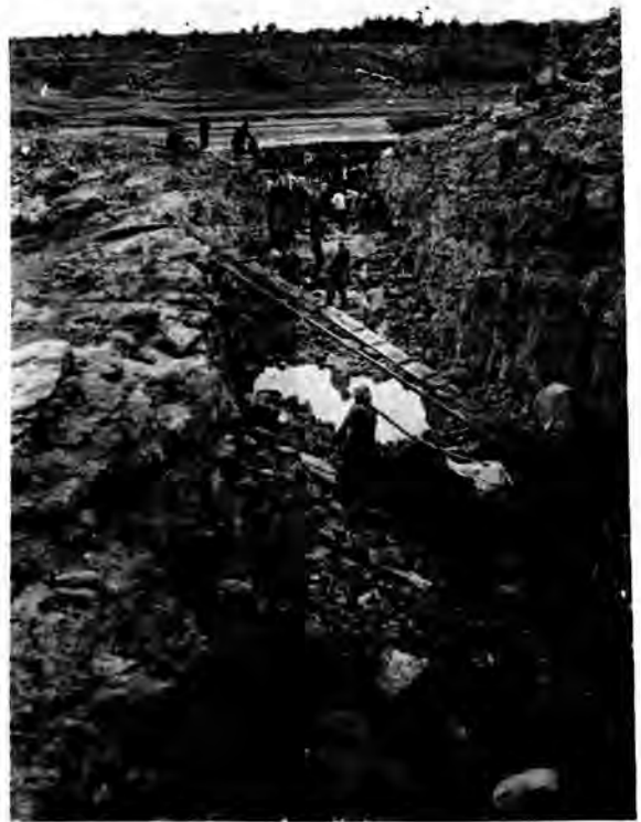
图 2—2 导流石渠施工
