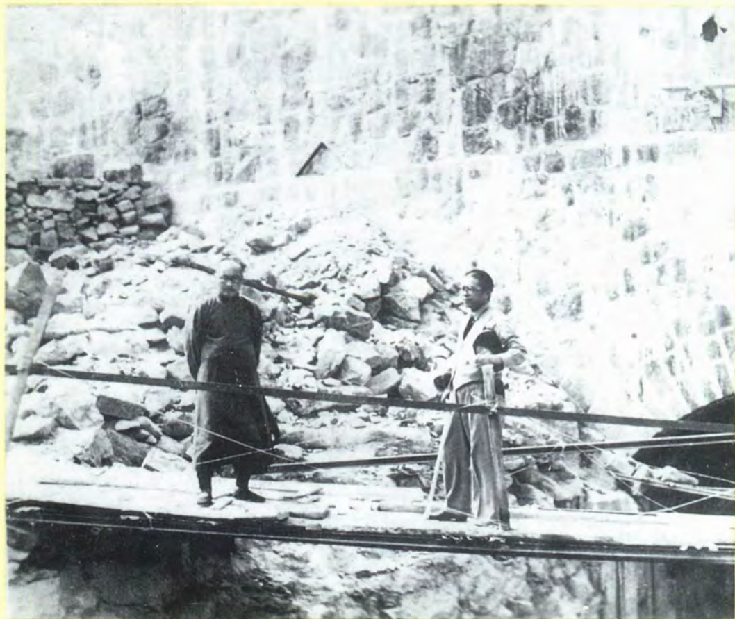
杨虎城(右)与李仪祉(左)1934年在洛惠渠工地
