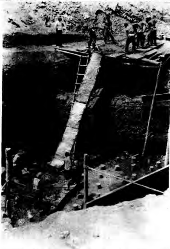
图 2—7 夺村渡槽基础施工
