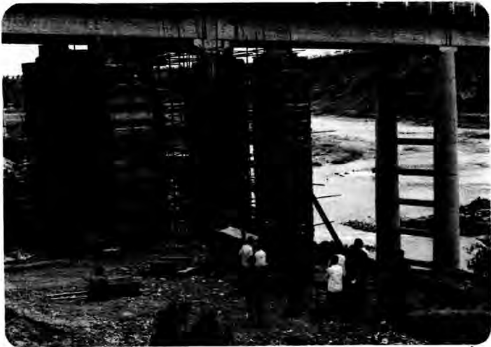
图5—4 洛西倒虹抢险施工
