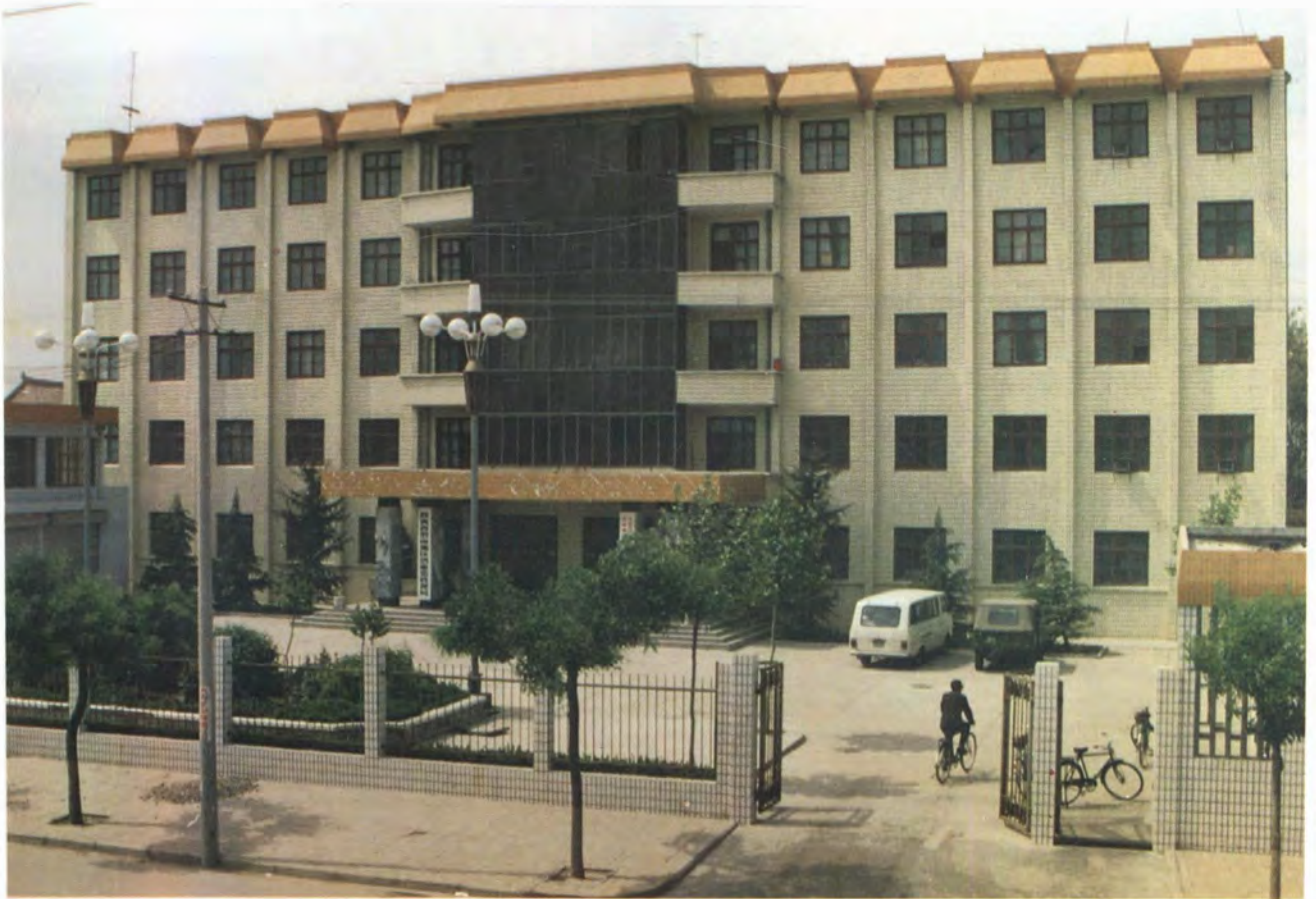
洛惠渠管理局办公大楼
