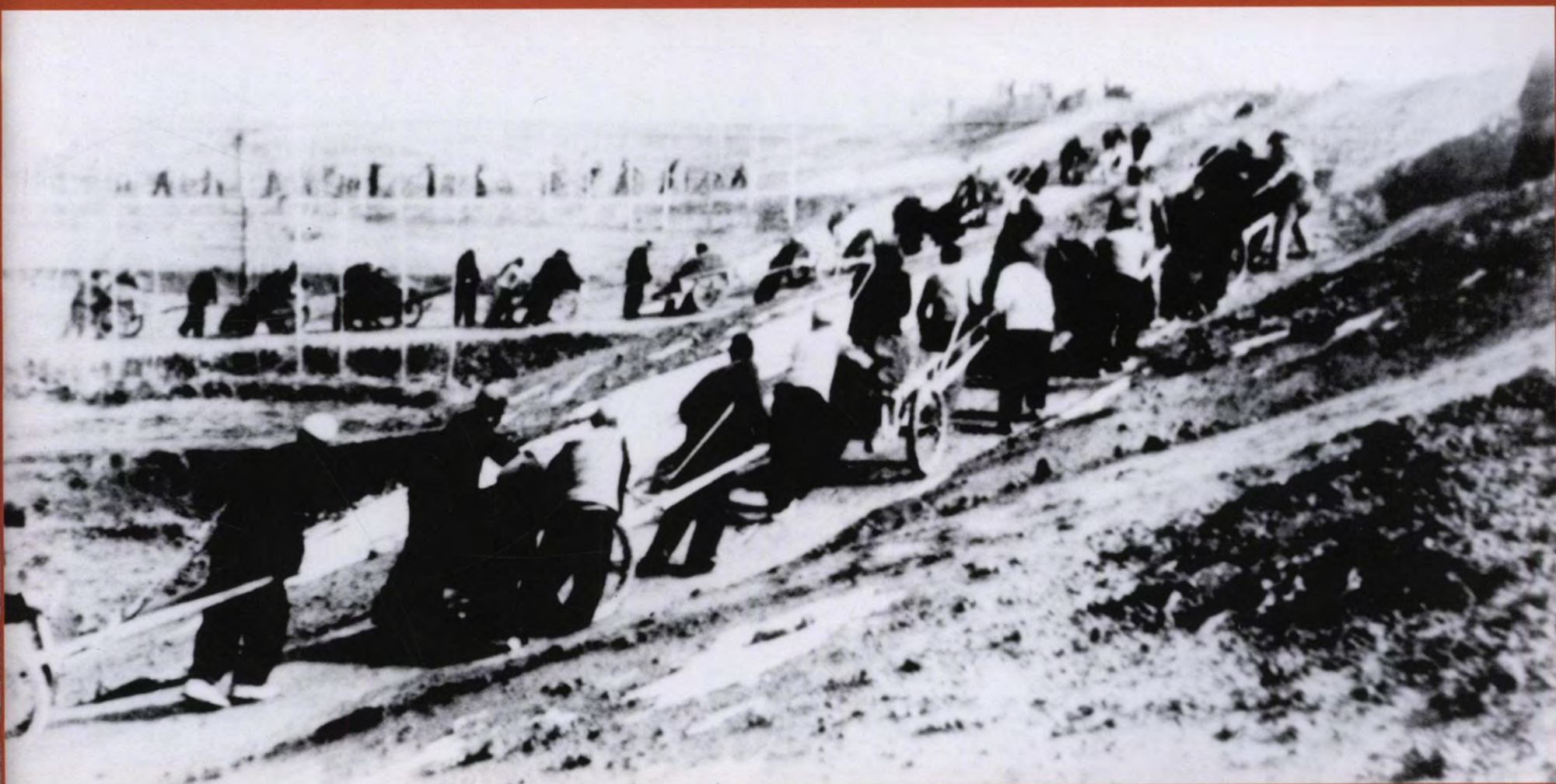
六十年代初 库区人民修建渭河大堤
