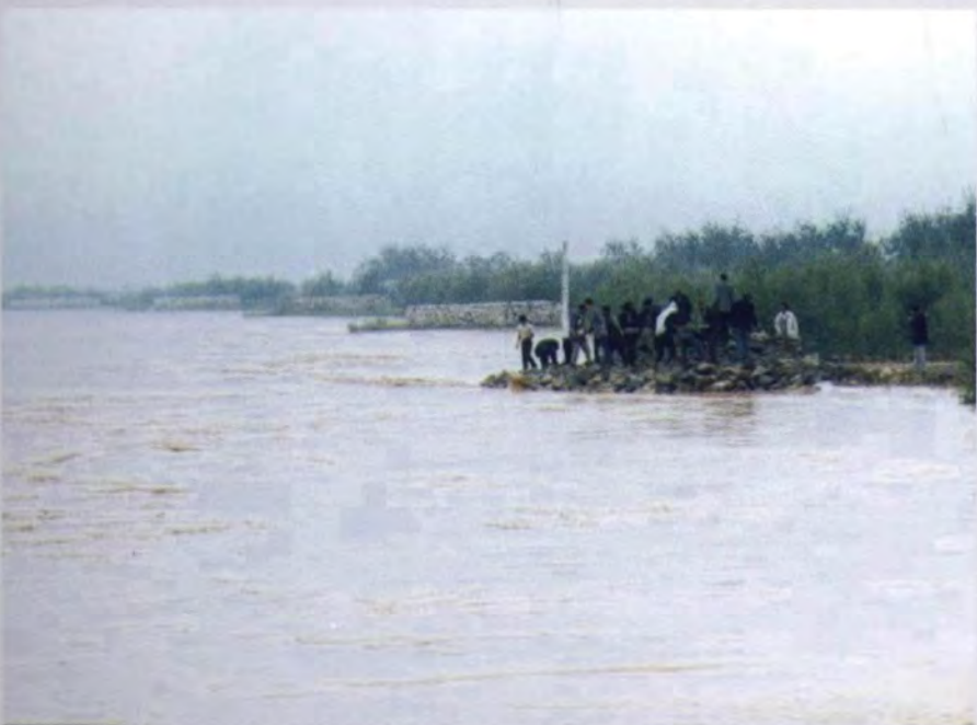
洪水早期华阴河务局抛投根石保护工程
