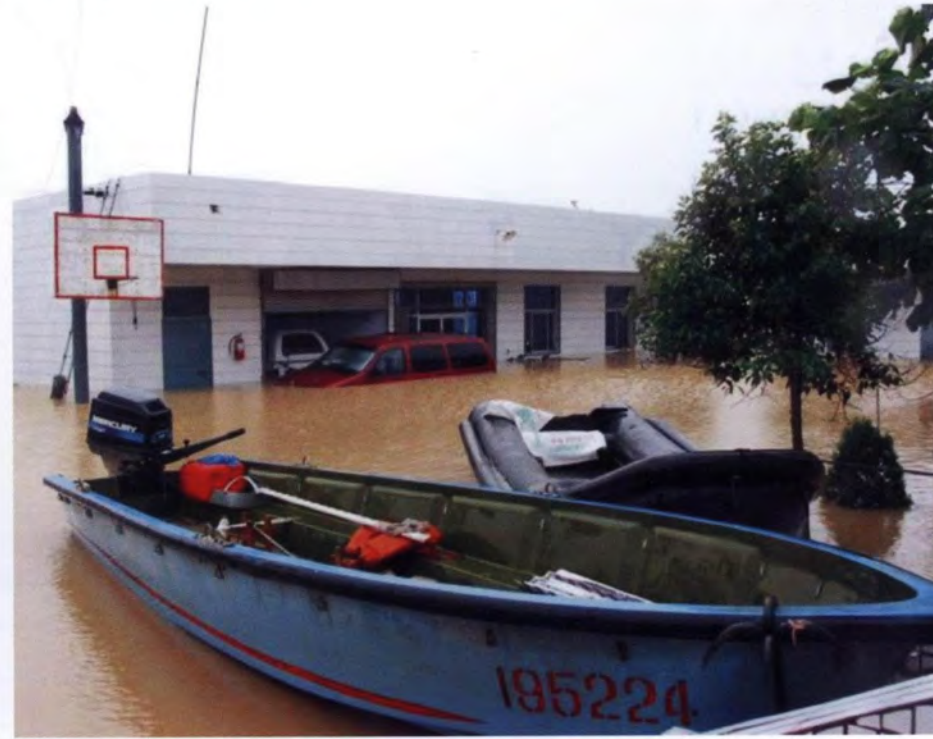
华县水文站院内洪水
