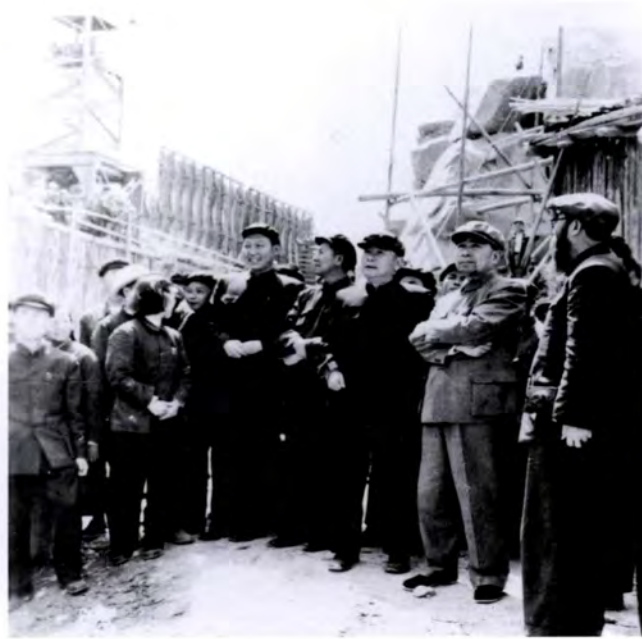
周恩来总理在三门峡大坝工地视察
