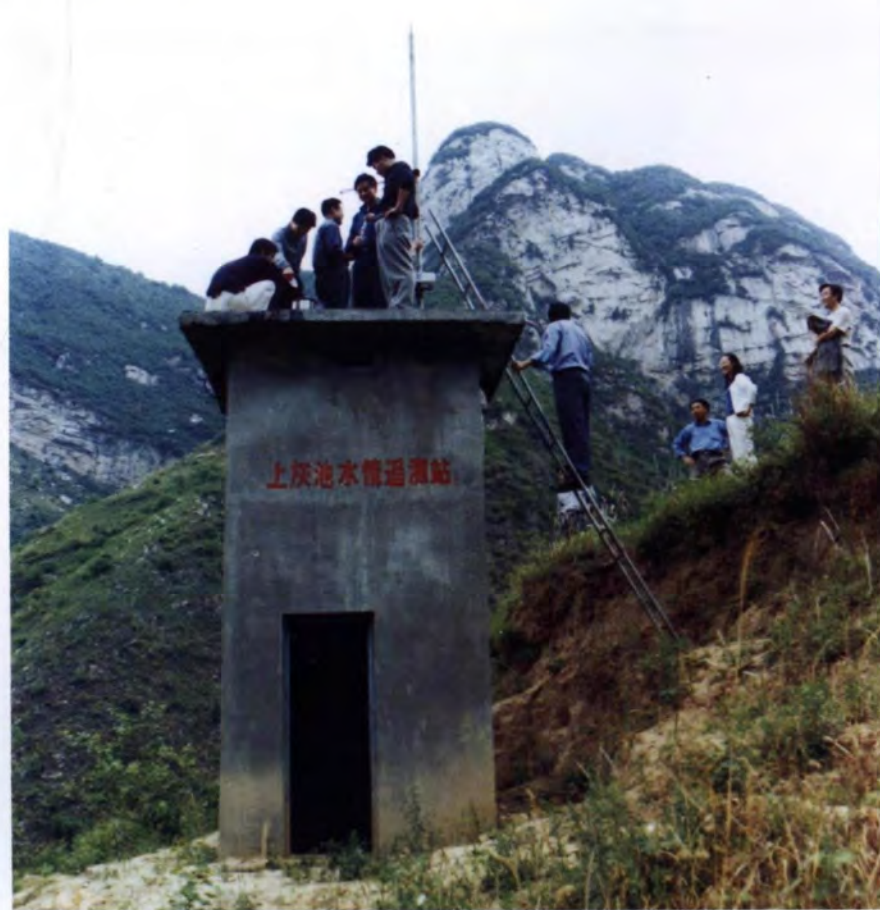
检查维护南山支流雨量站
