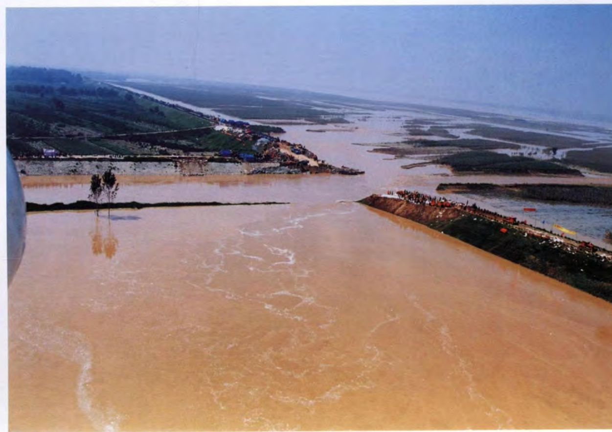
华县石堤河决口
