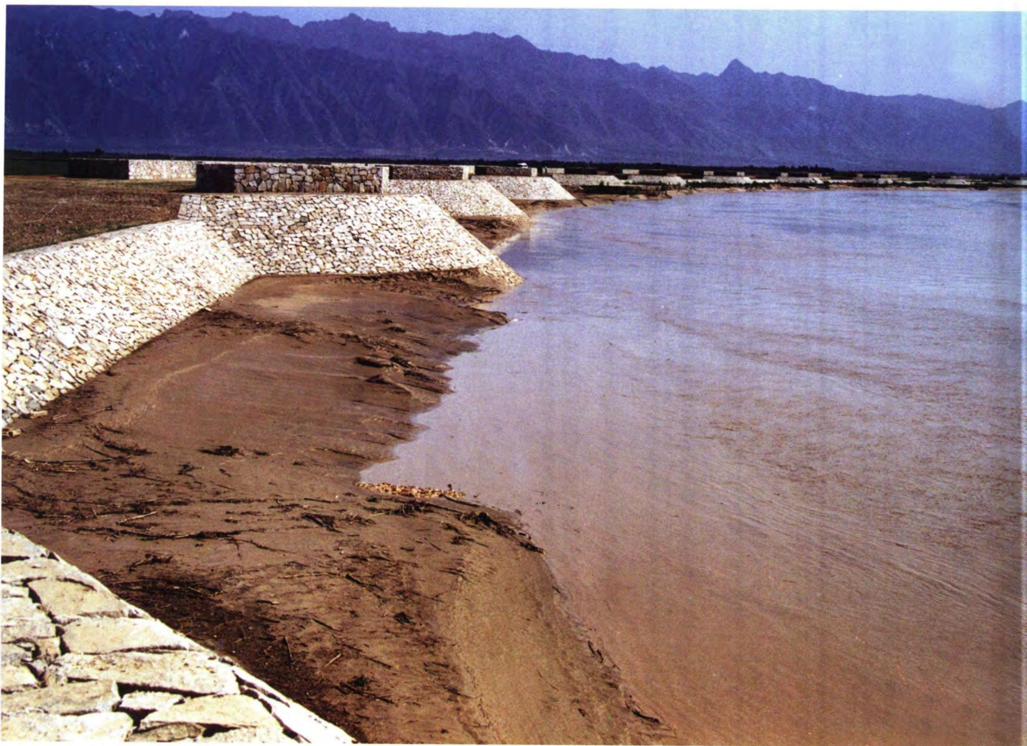
华阴冯东河道工程
