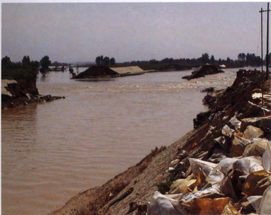
9月1日3时，罗纹河口东堤100米处决口，9月8日23时45分，东堤300米处决口，8日22时，西堤200米处决口。
