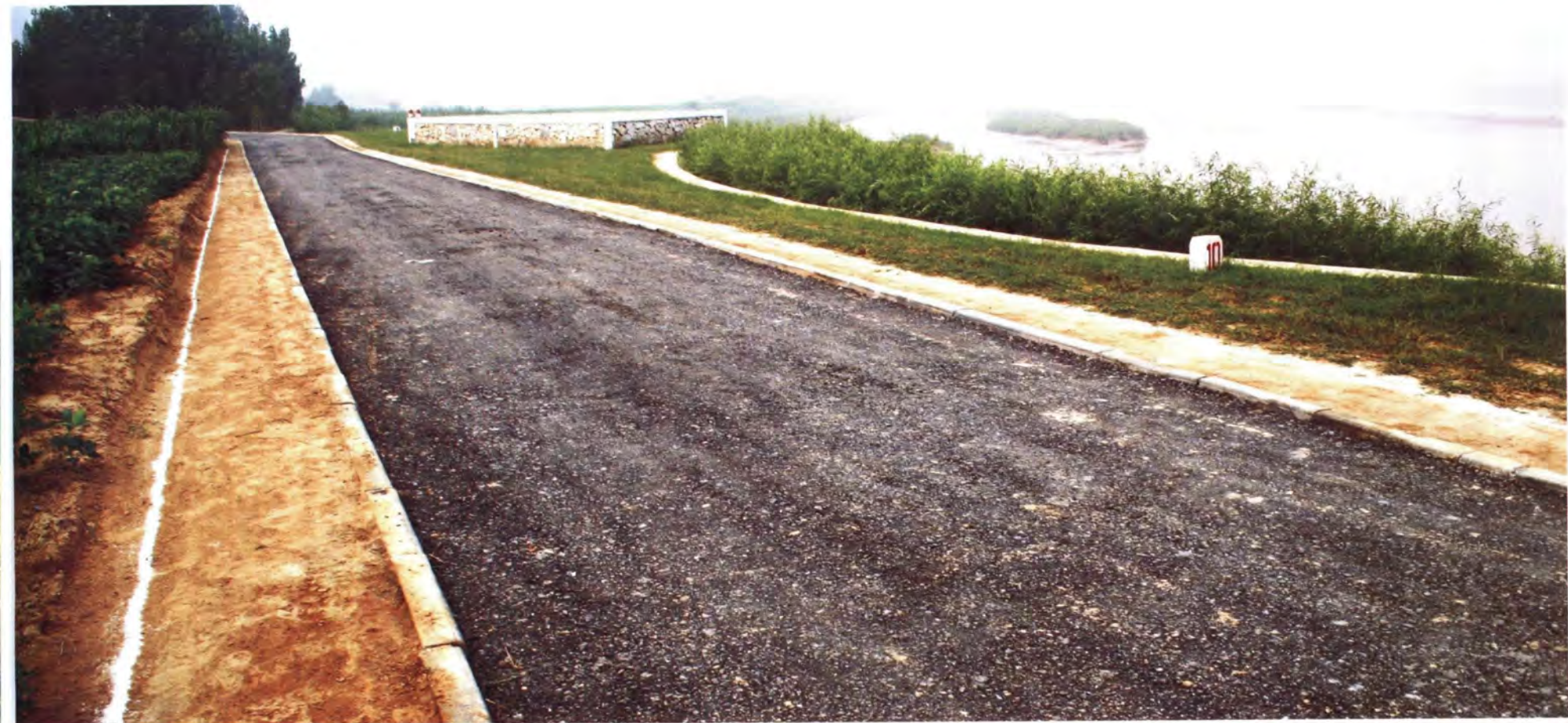
临渭区埝头险工连坝路
