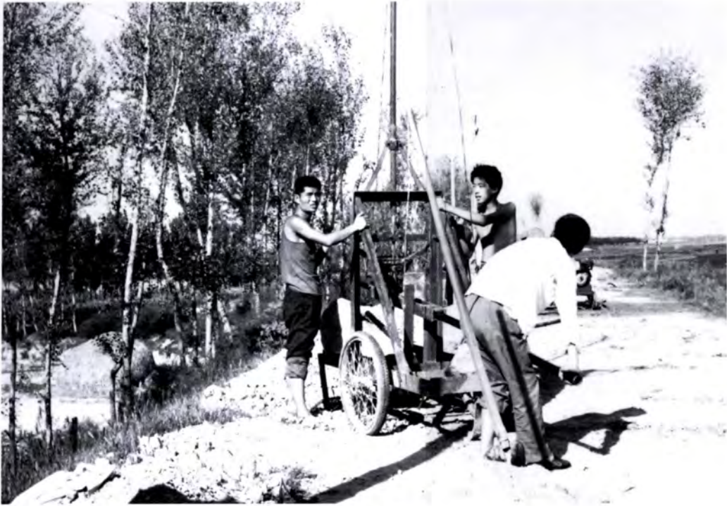
八十年代成立的灌浆队，对渭河大堤进行灌浆加固。
