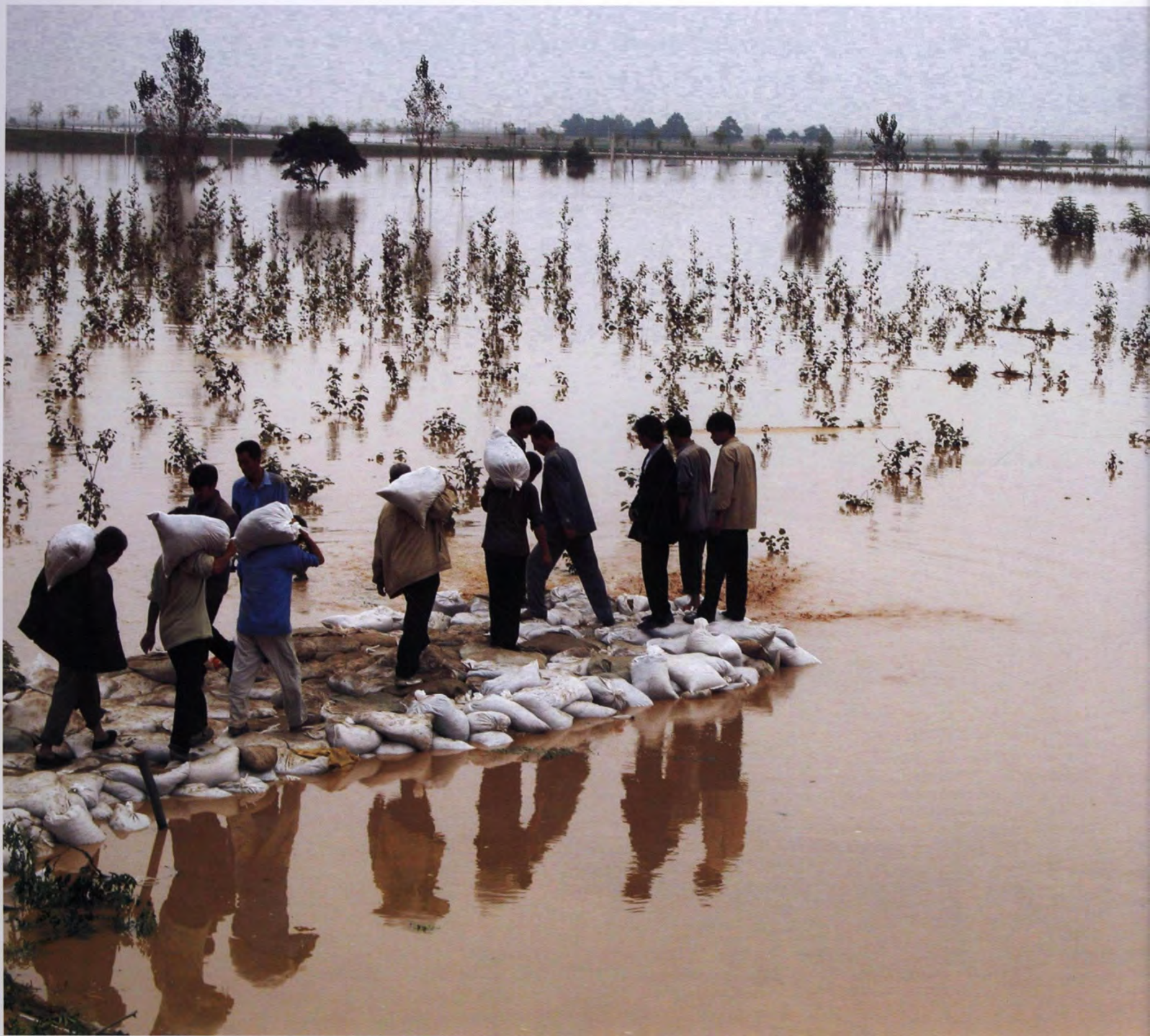
大荔渭河大堤封堵渗漏
