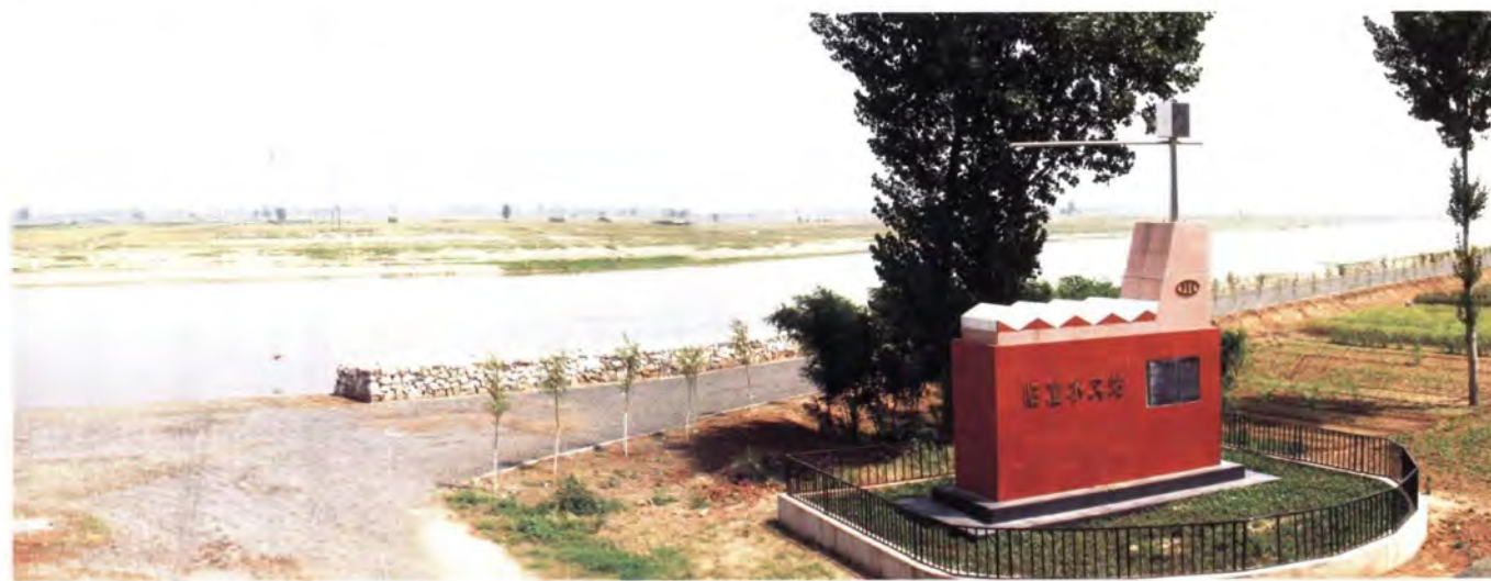
临潼水文站河段险工
