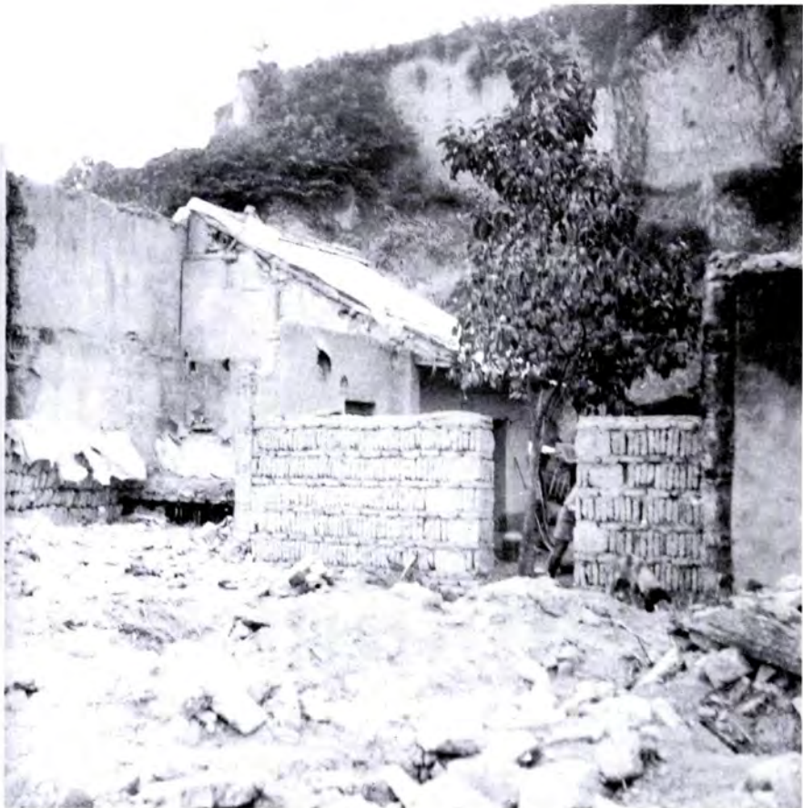
梁村塌岸后村民倒塌的房屋
