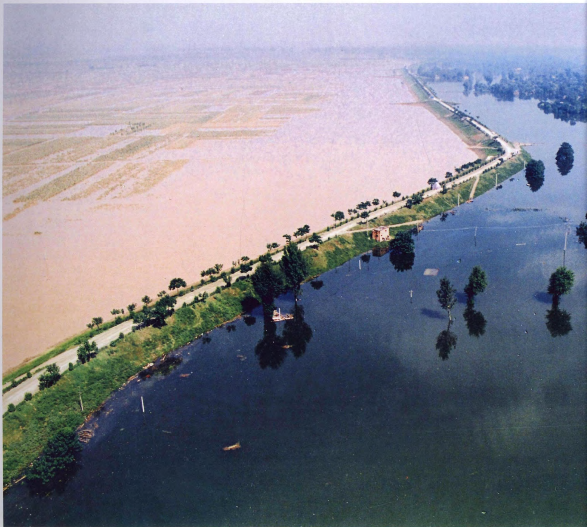
华县石堤河决口后渭河大堤内外的洪水
