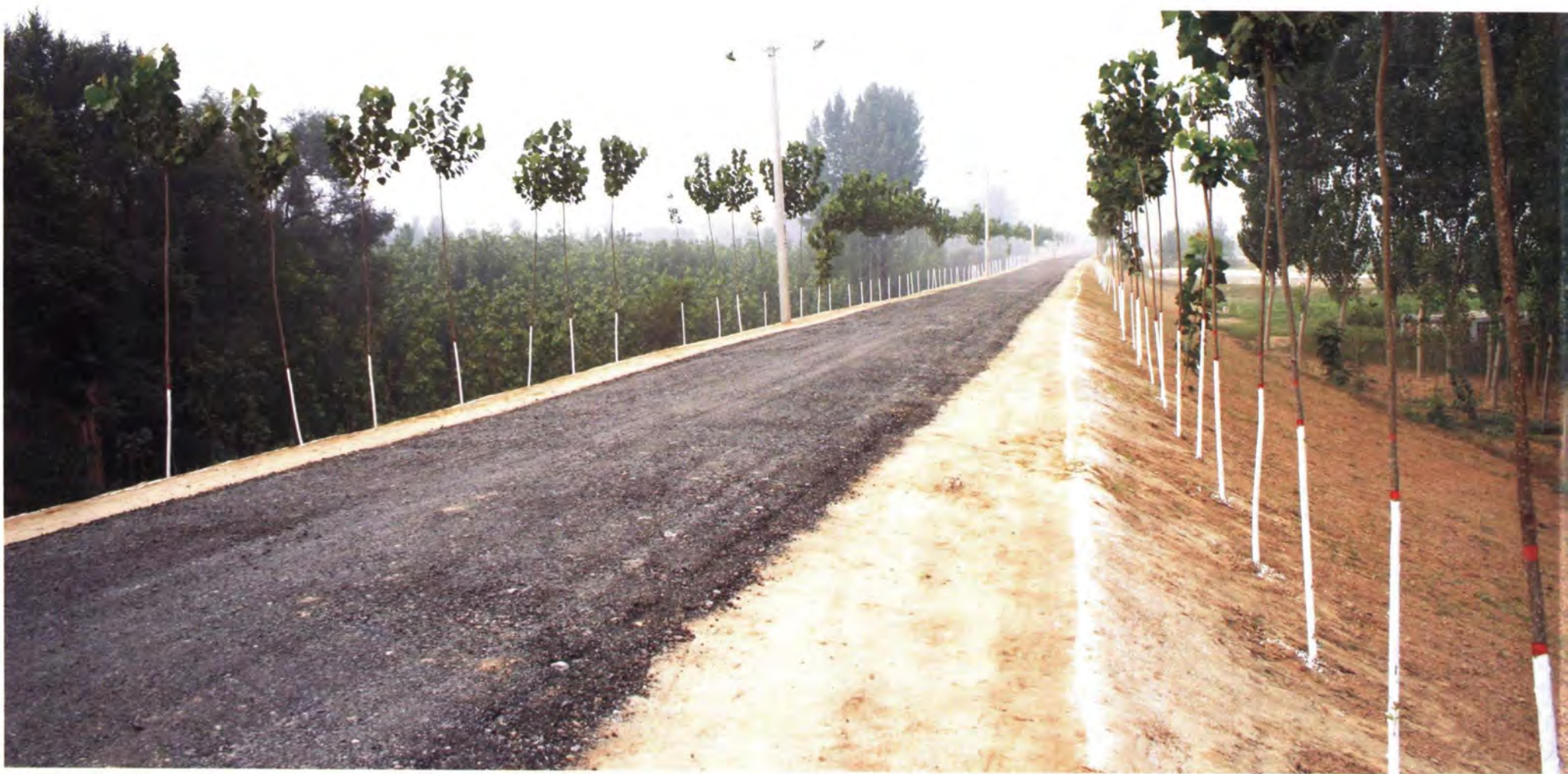
渭南埝头堤防
