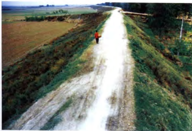
1998年，华县遇仙河口东段渭河大堤临背差。
