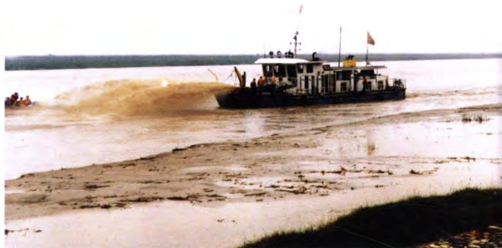
2003年9月5日，拖淤船在潼关吊桥进行清淤工作。
