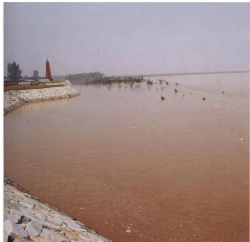
华阴北罗湾移民围堤0+300处洪水
