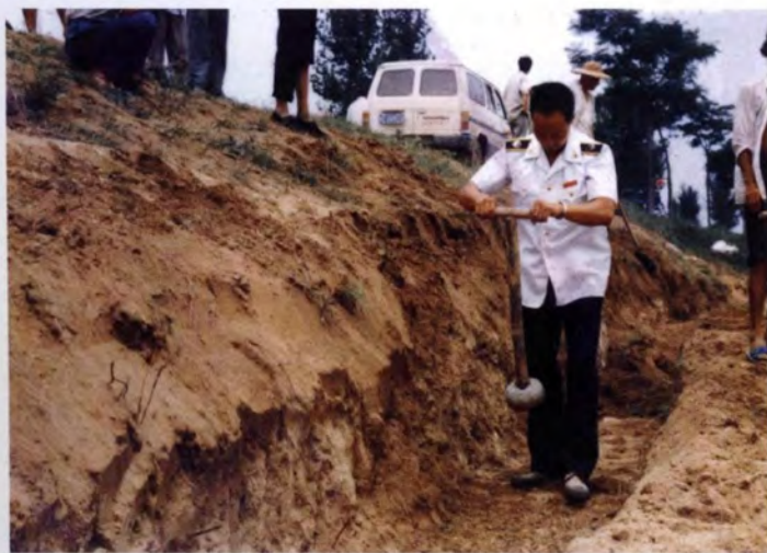
1996年8月，渭河堤防陈村险段回填夯实。
