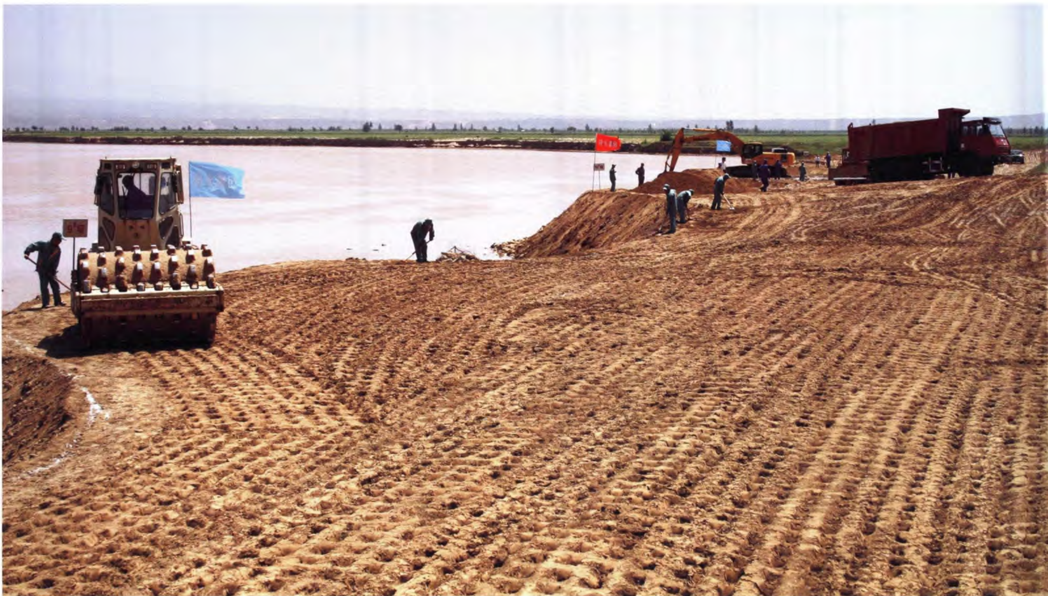
河道险工主体施工
