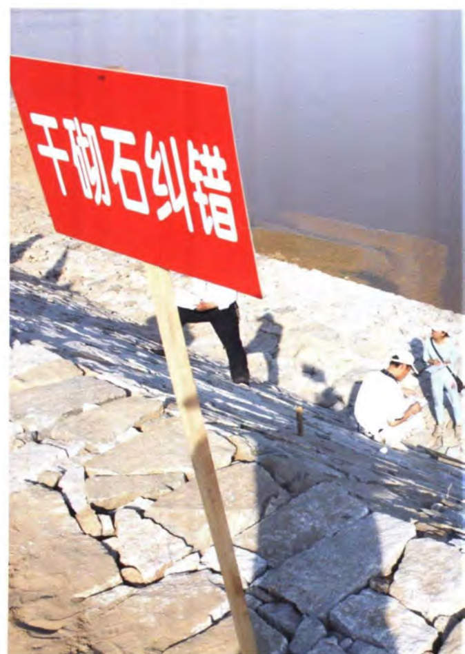
河道工程砌石交错比武现场
