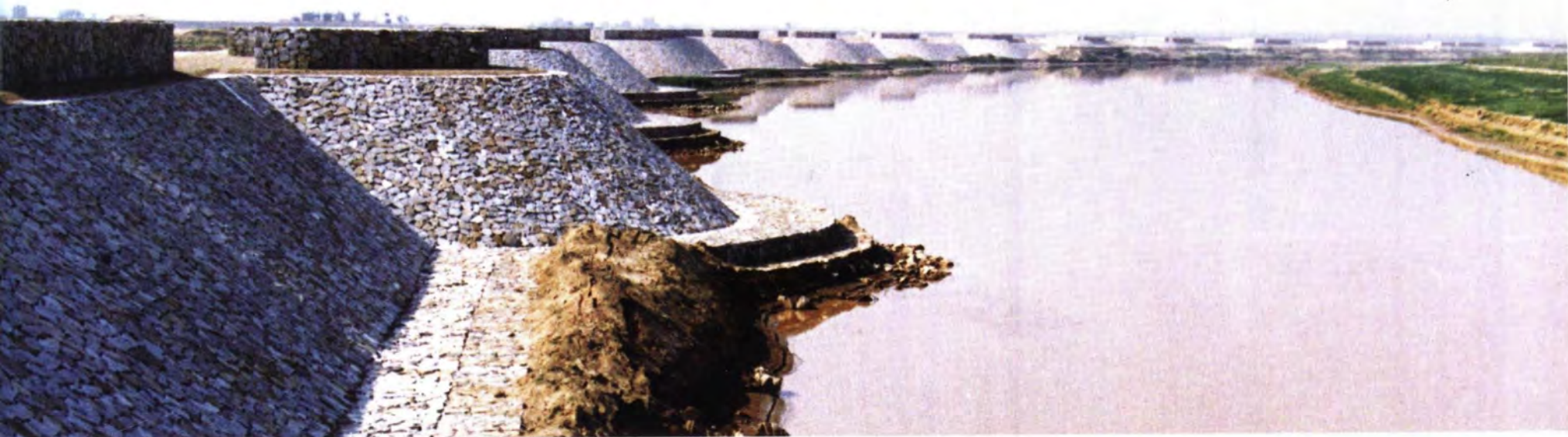
华县北拾河道工程
