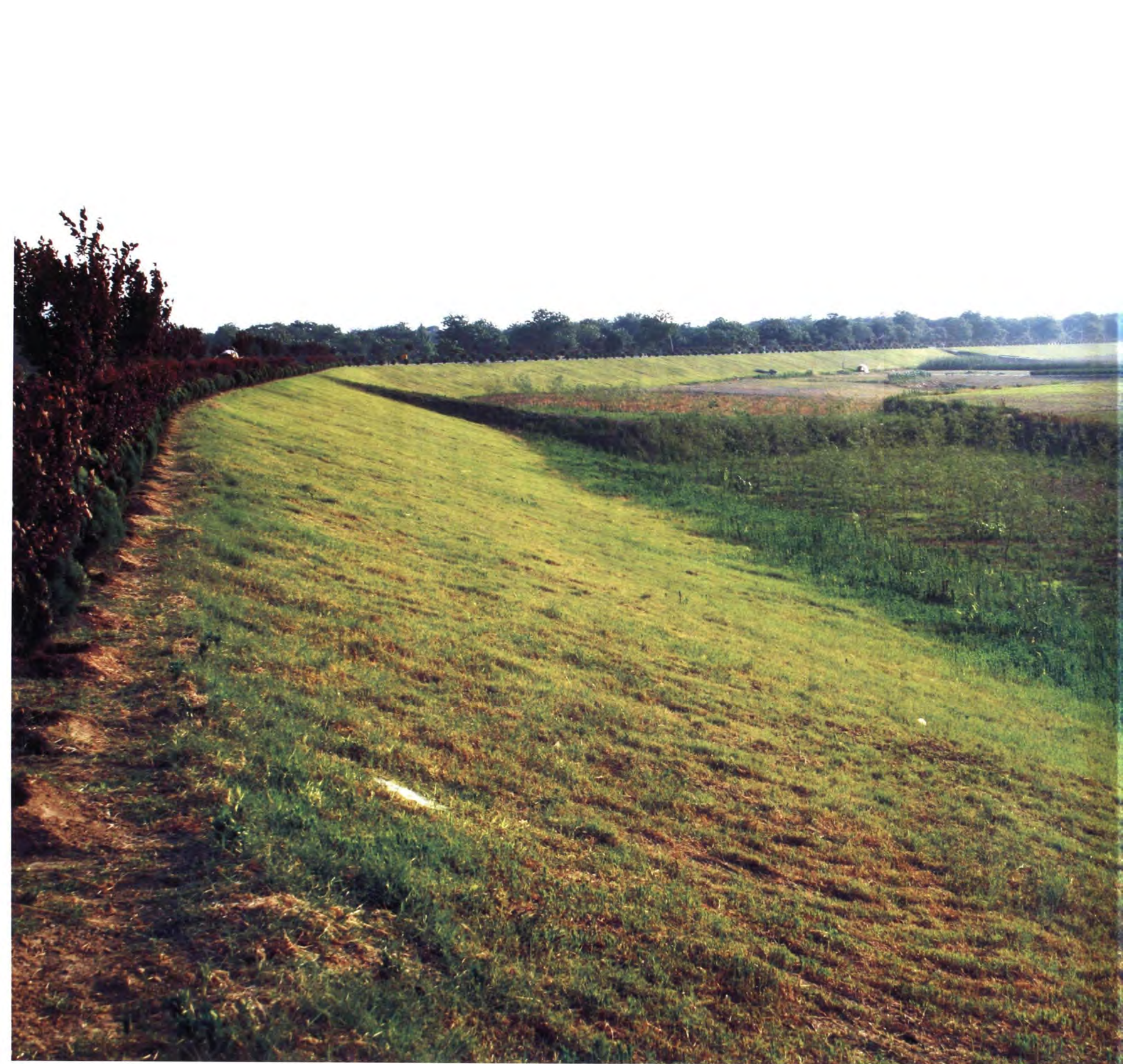
人工植草护坡的渭河堤防
