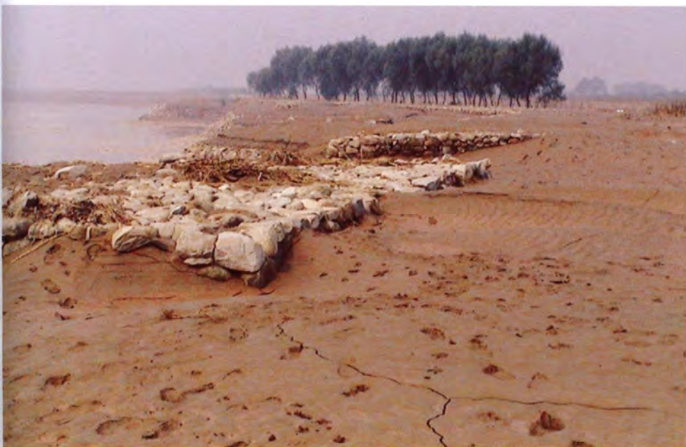
2003年8月，渭河洪水后渭南临渭区八里店险工备方石被淤埋。
