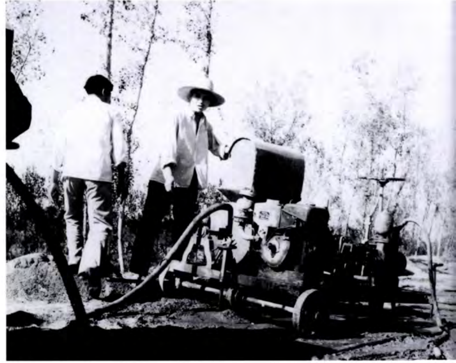
1984年，渭南渭河大堤灌浆施工。
