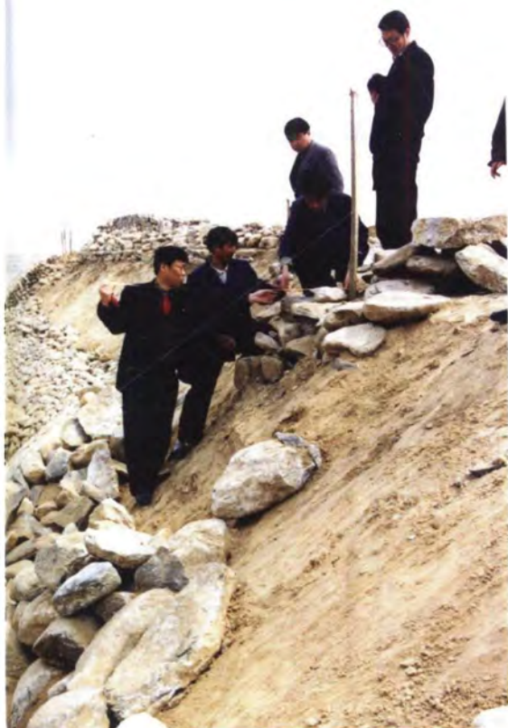
抽检施工质量
