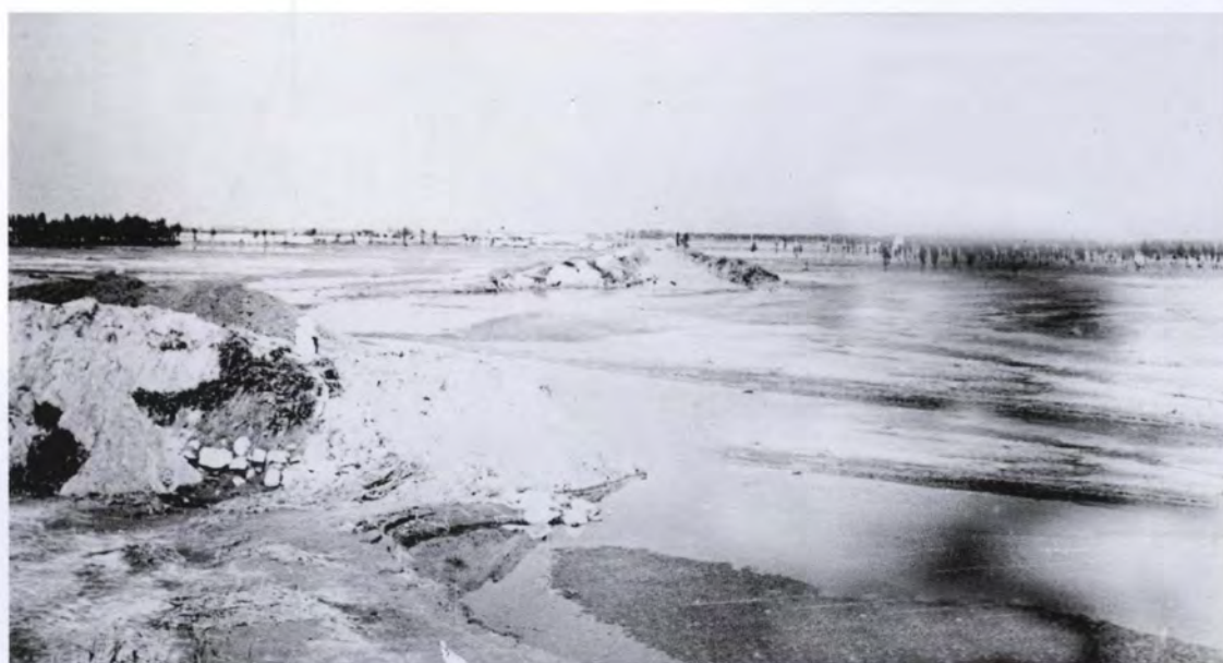
华阴南山支流罗夫河东堤决口，二华排水干沟1800米基本淤平。
