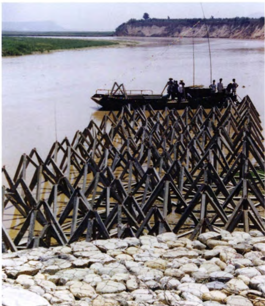
1999年5月，潼关吊桥控导工程四面六边框架筑坝。
