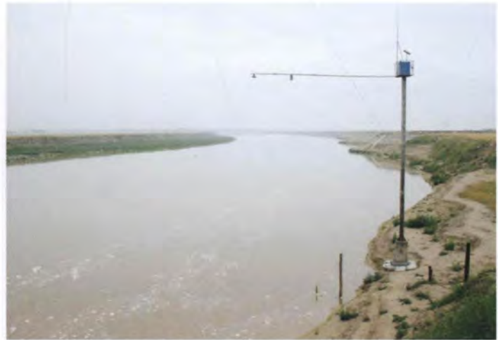
临渭区八里店水文遥测点
