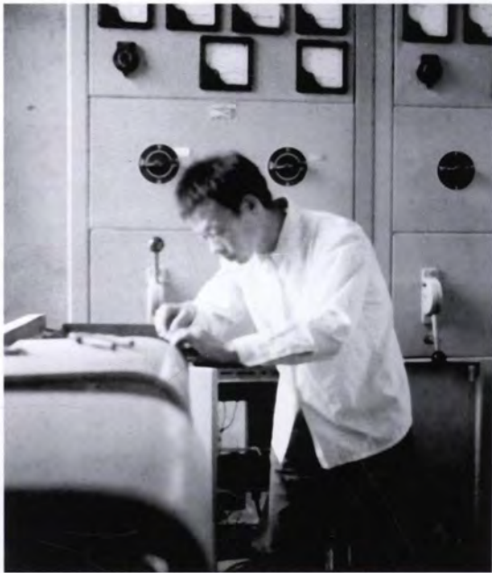
七十年代华县方山排水站职工检修机组
