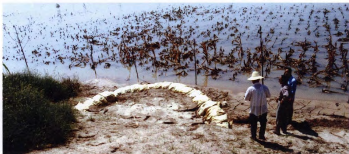
1996年8月，华县渭河大堤堵渗围堰。
