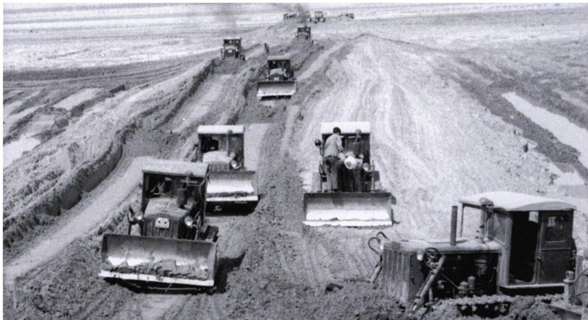
八十年代机械施工队进行渭河河道工程土方施工
