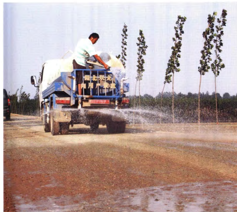
大堤洒水养护
