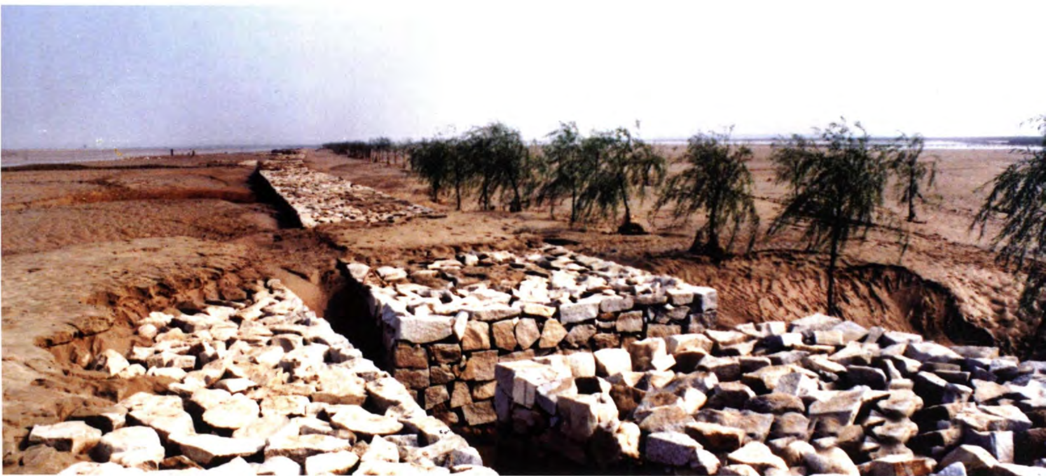
2003年8月渭河洪水后，华县台台险工被淤埋的备防石。
