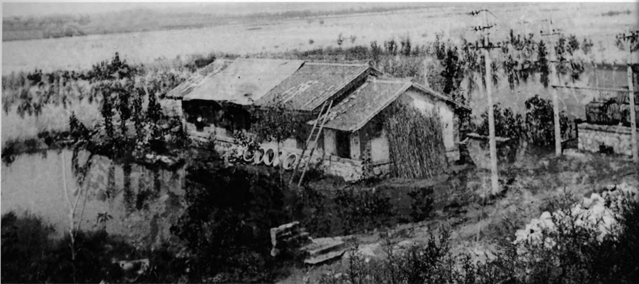
方山河抽水站
