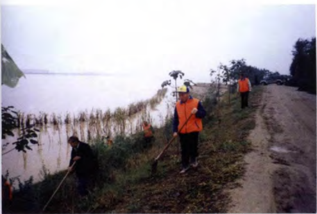
2000年10月13日，临渭区组织群众巡堤查险。
