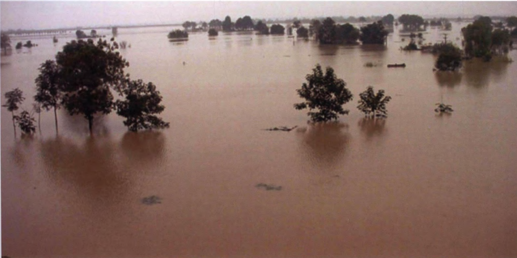
大荔新兴险工全面漫顶
