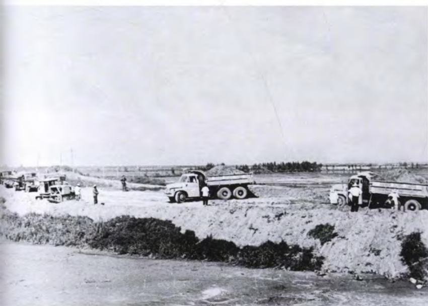
华阴南山支流罗夫河决口机械堵口施工
