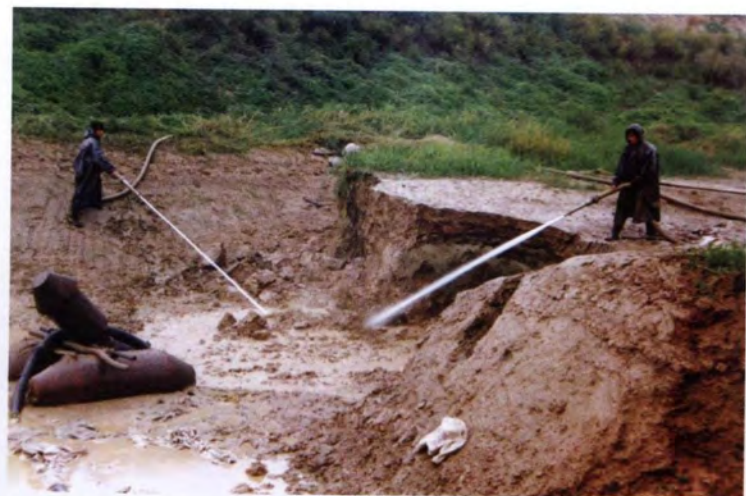
1998年，罗纹河淤背工程施工。
