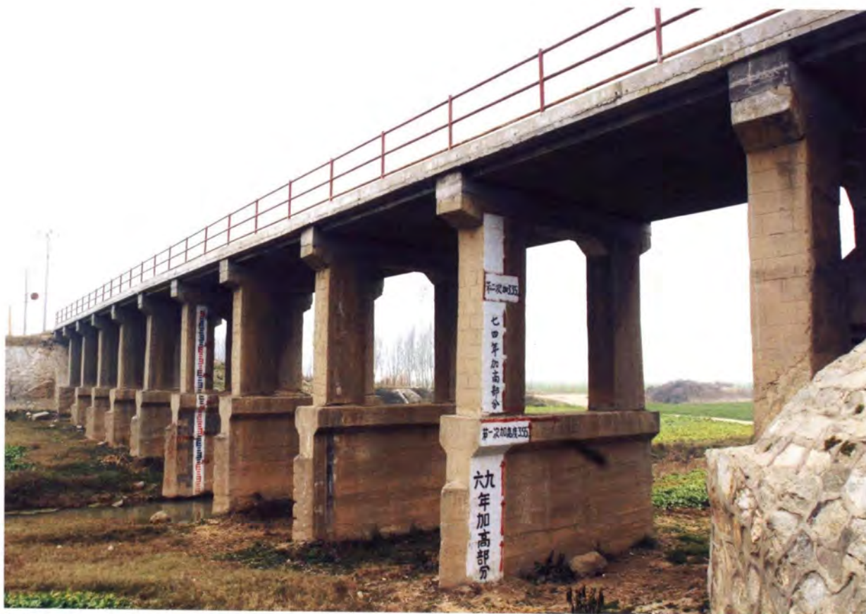
经过三次加高的华县南山支流遇仙河口桥
