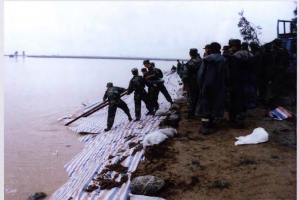
2003年9月1，华阴围堤1公里处抢堵漏洞。
