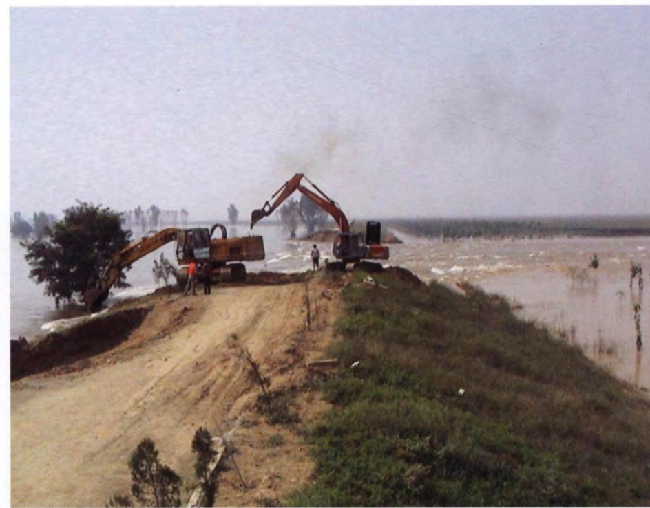
华阴北罗湾处破堤泻洪作业
