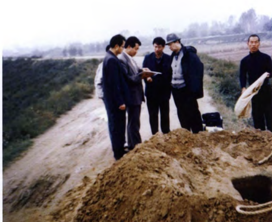
渭河大堤质量检测开挖探井
