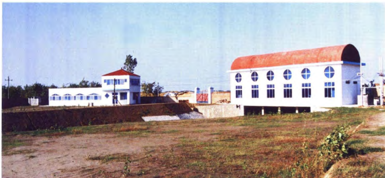
建成的华阴林家寨排水站
