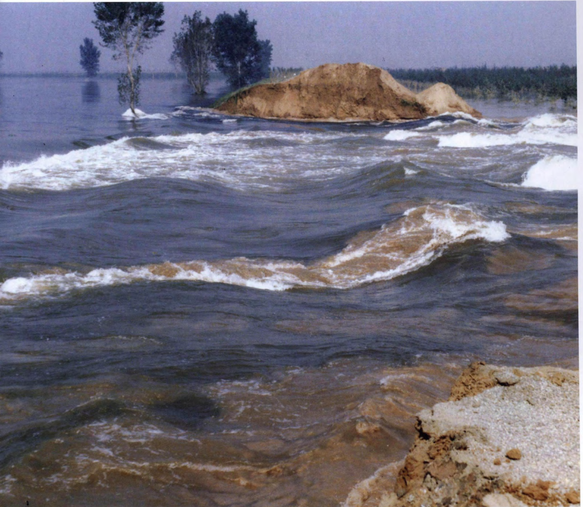
2003年9月11日，华阴围堤11+100处人工破堤150米，洪水冲泻后，破堤处豁口拉开至300米。
