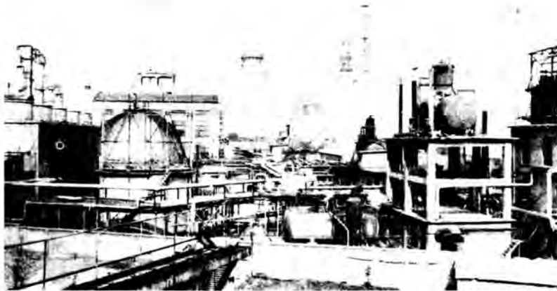
陕西最大的化肥厂——兴平化肥厂生产区一角
