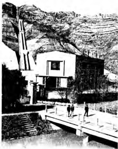
东雷二级抽水站 (李双乾摄)
