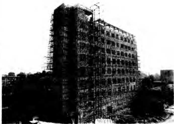
正在建设中的西安人民搪瓷厂工艺品生产大楼
