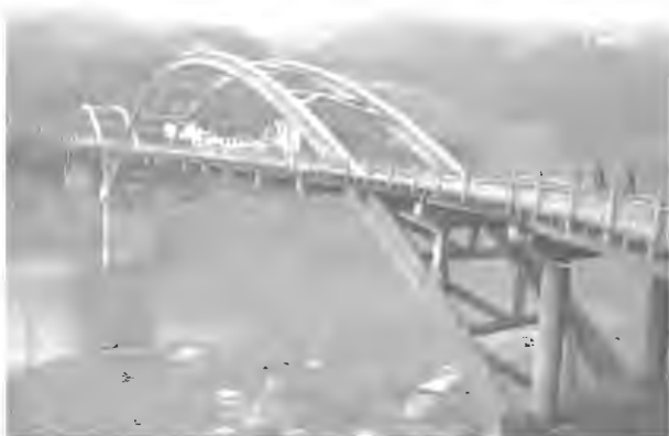
蜀河镇汉江大桥
