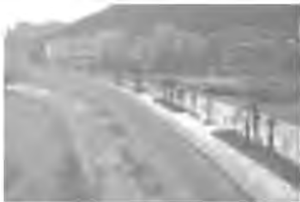
党家坝堤防工程
