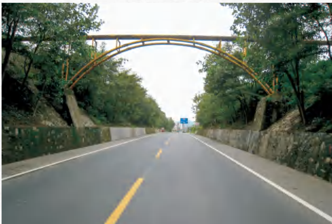
316国道横过公路渠管道（2008年8月30日拍摄）
