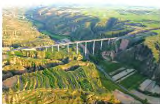
108国道金水沟大桥
