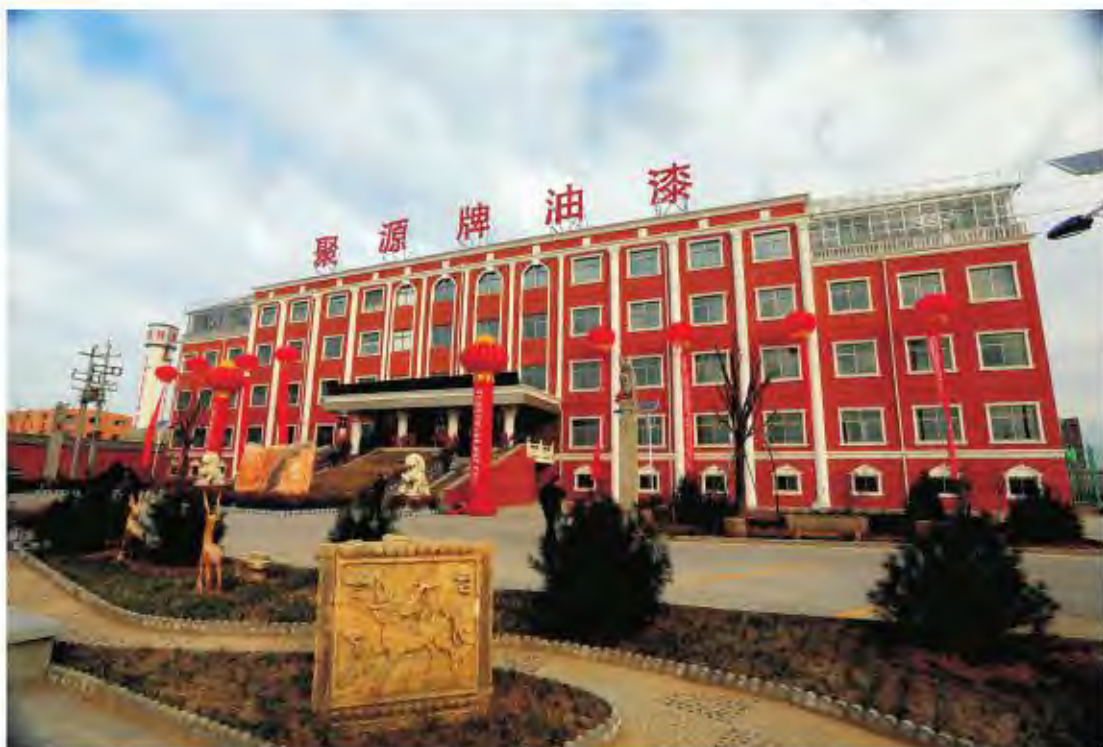
陕西源源化工有限责任公司办公楼
