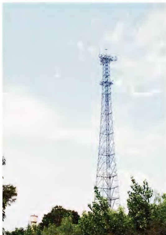
潼关移动通信基站
