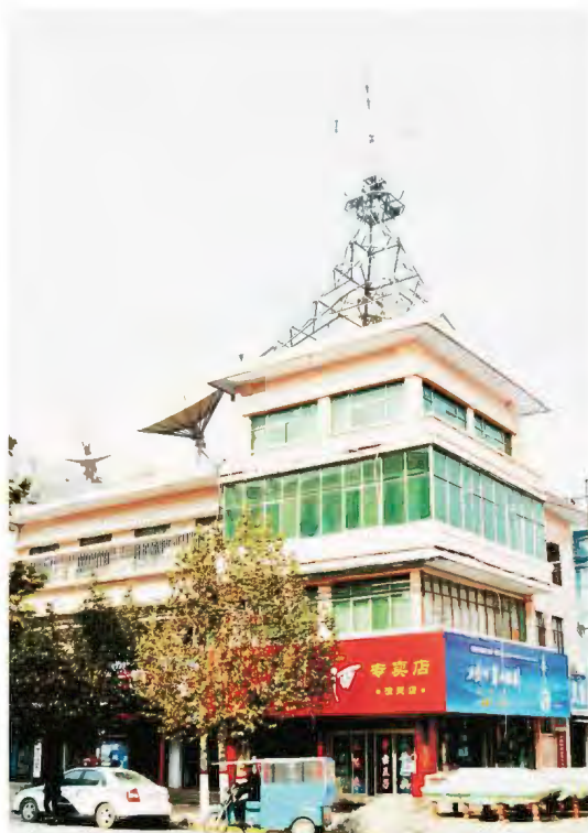
广播电视大楼
