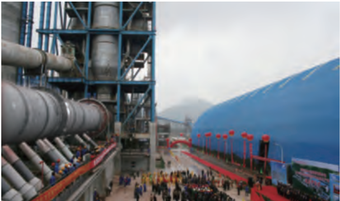
陕西实丰水泥股份有限公司年产200万吨水泥生产线
