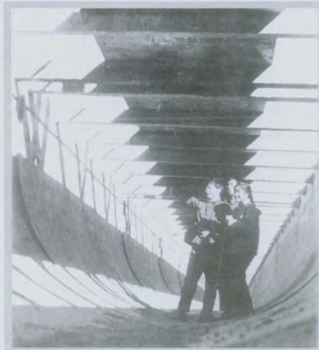
南江水电站渡槽
