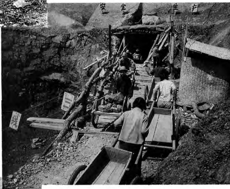
民兵修建阳安铁路
