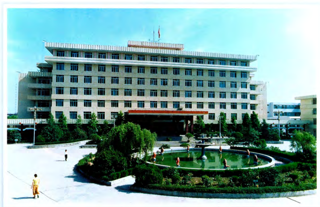
▲ 安康地区行政公署办公大楼
