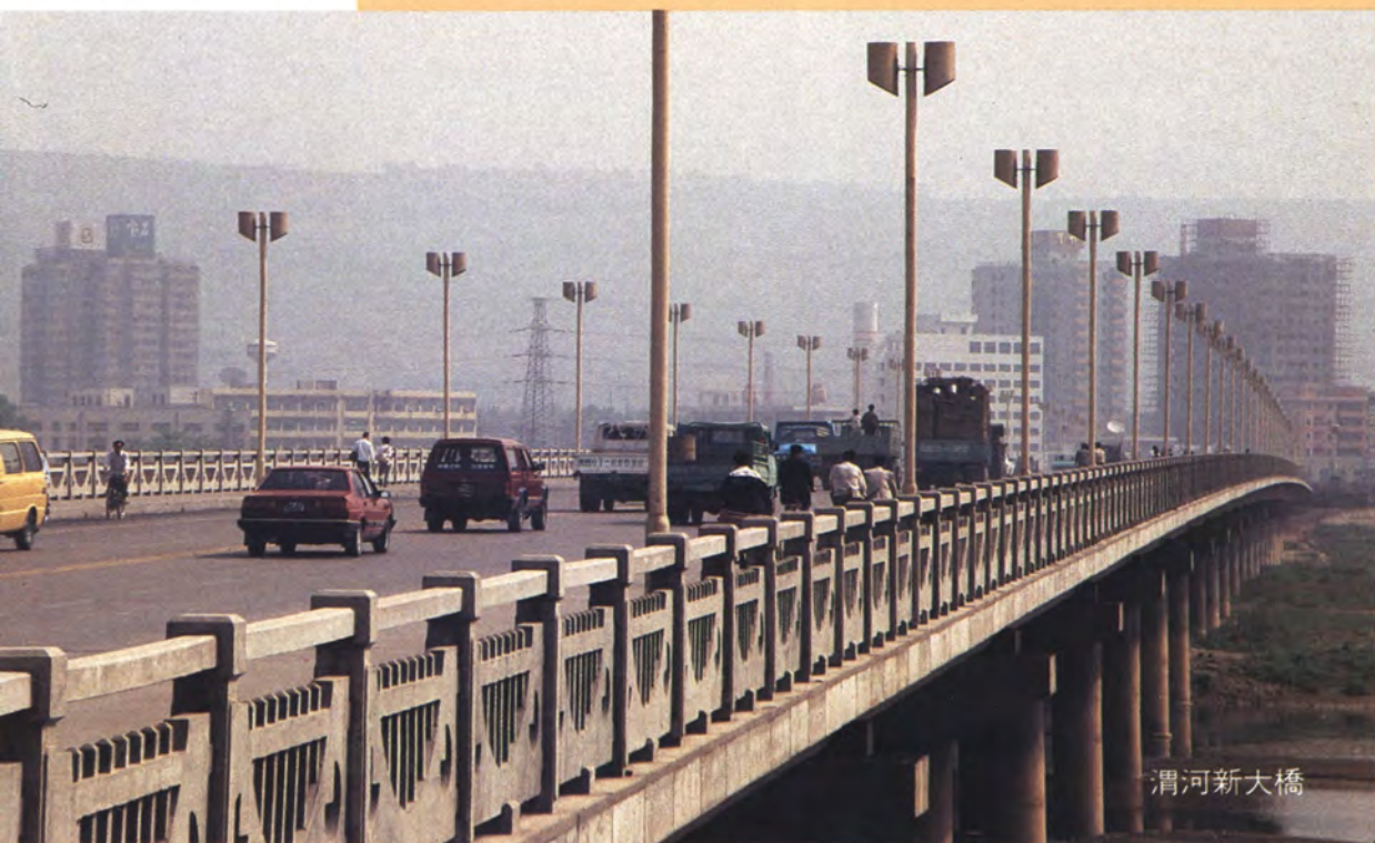
渭河勝利大橋
