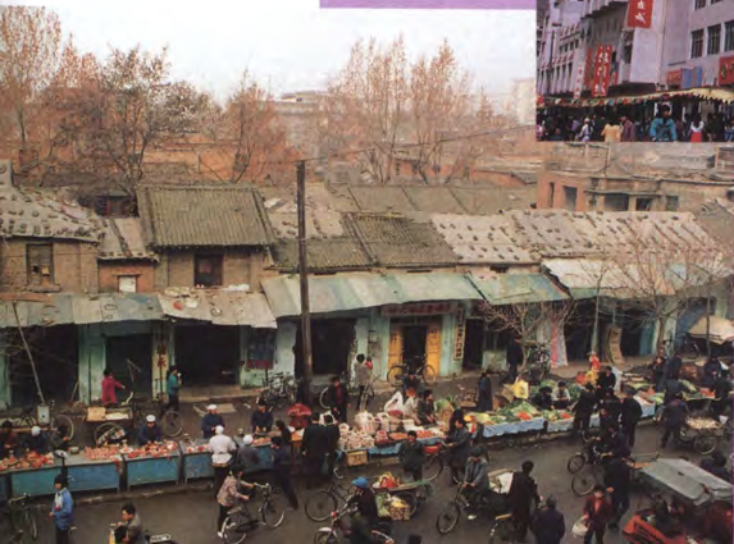
拆遷改造前的舊解放市場
