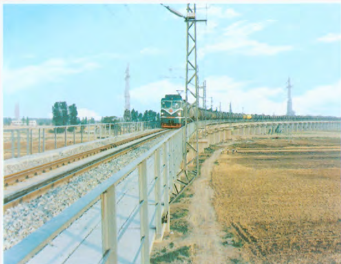
◀ 宝(鸡)中(卫)铁路干河大桥
