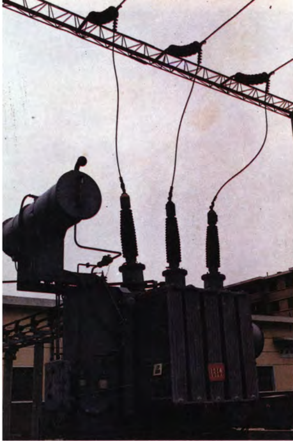
扶风变压器厂生产的SFZ 7 -2000/100 有载调压电力变压器(部优产品)
