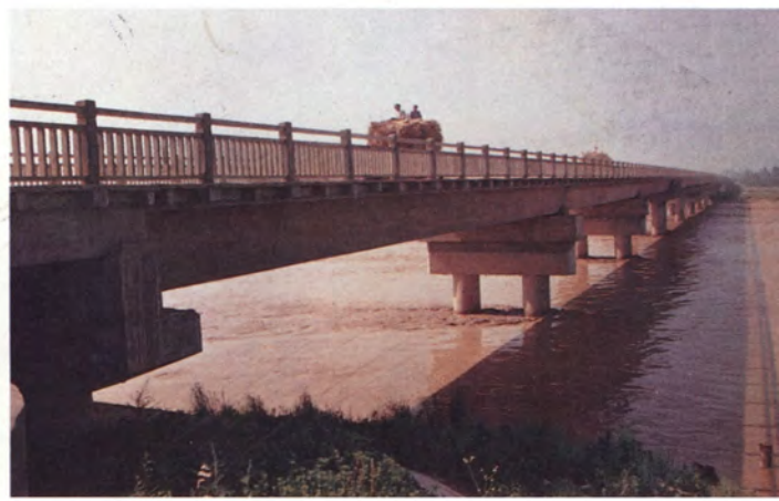
国内第一座由农民集资修建的大型跨河桥梁 ——渭河罗家大桥
