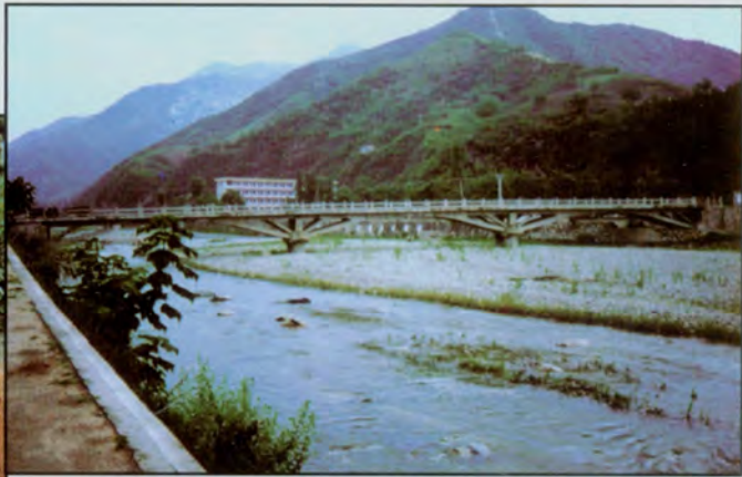
柞水下梁乾佑河公路大桥
