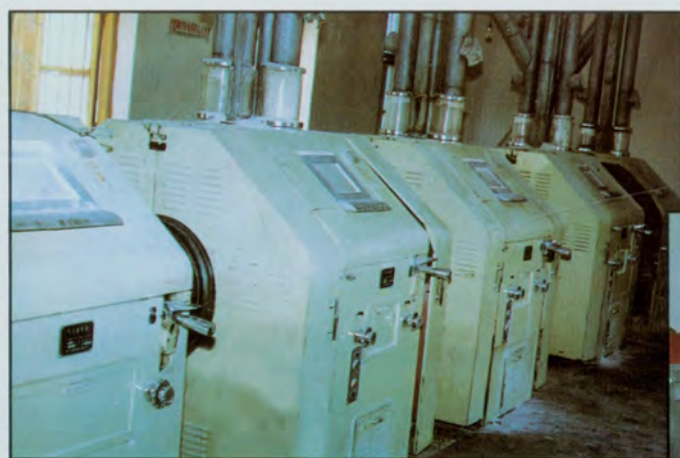
柞水县面粉厂主机车间
