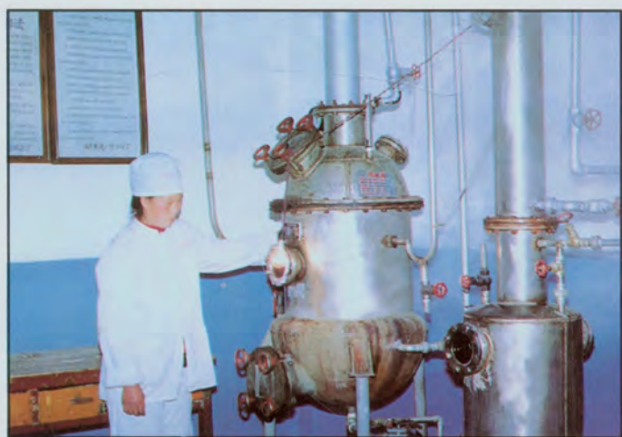
西安药厂柞水分厂浓缩车间
