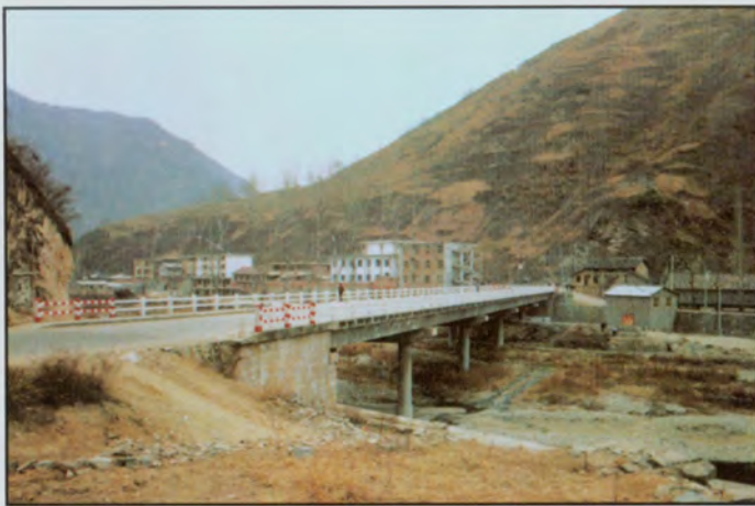
柞水商柞公路桃园乾佑河大桥
