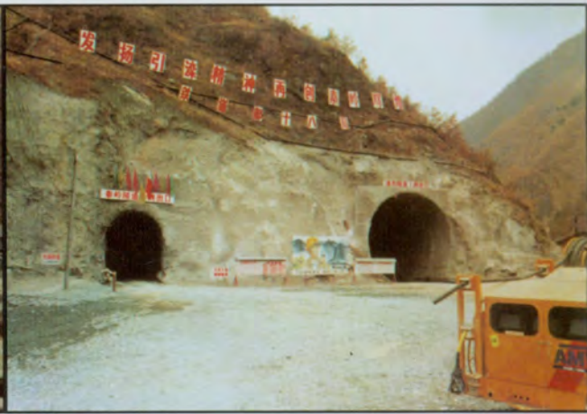
正在施工的西康铁路柞水秦岭隧道
