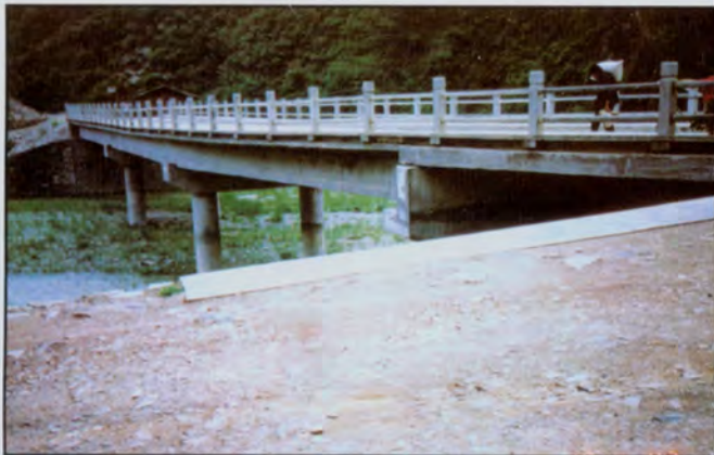
柞水商柞公路小河口大桥
