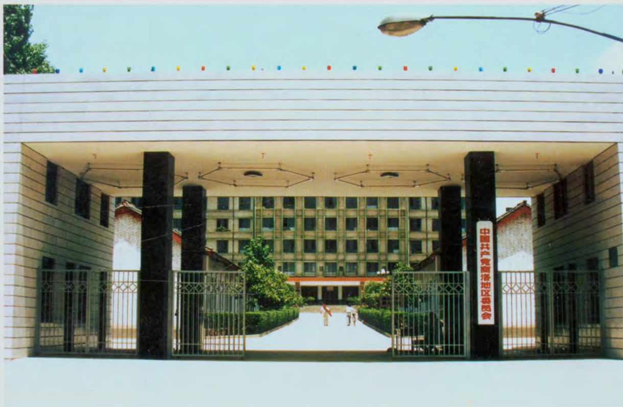
中共商洛地委办公大楼
