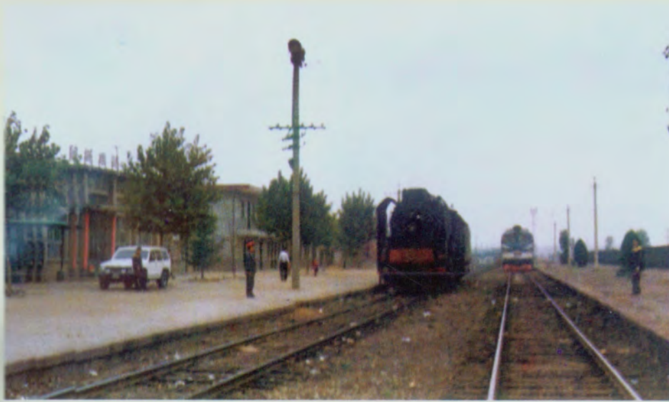
西延铁路蒲城车站
