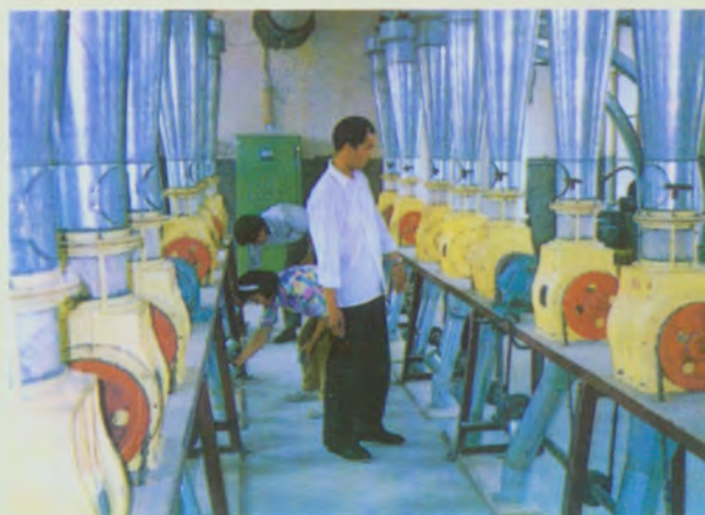
东陈镇东方面粉厂生产车间
