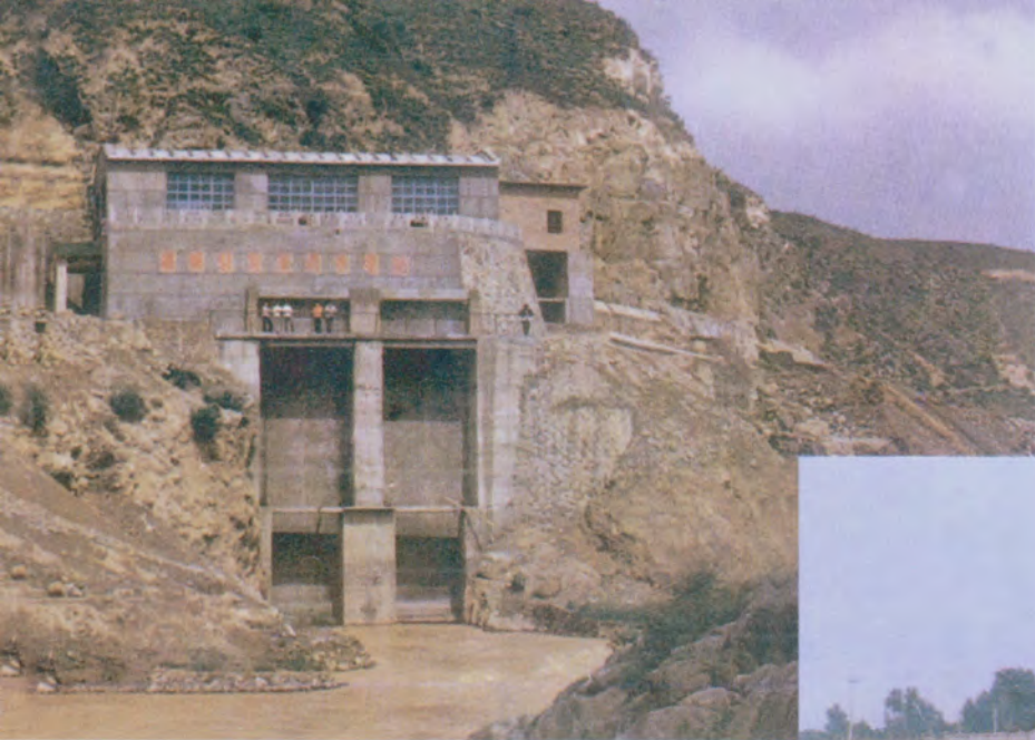
党家湾水电站
