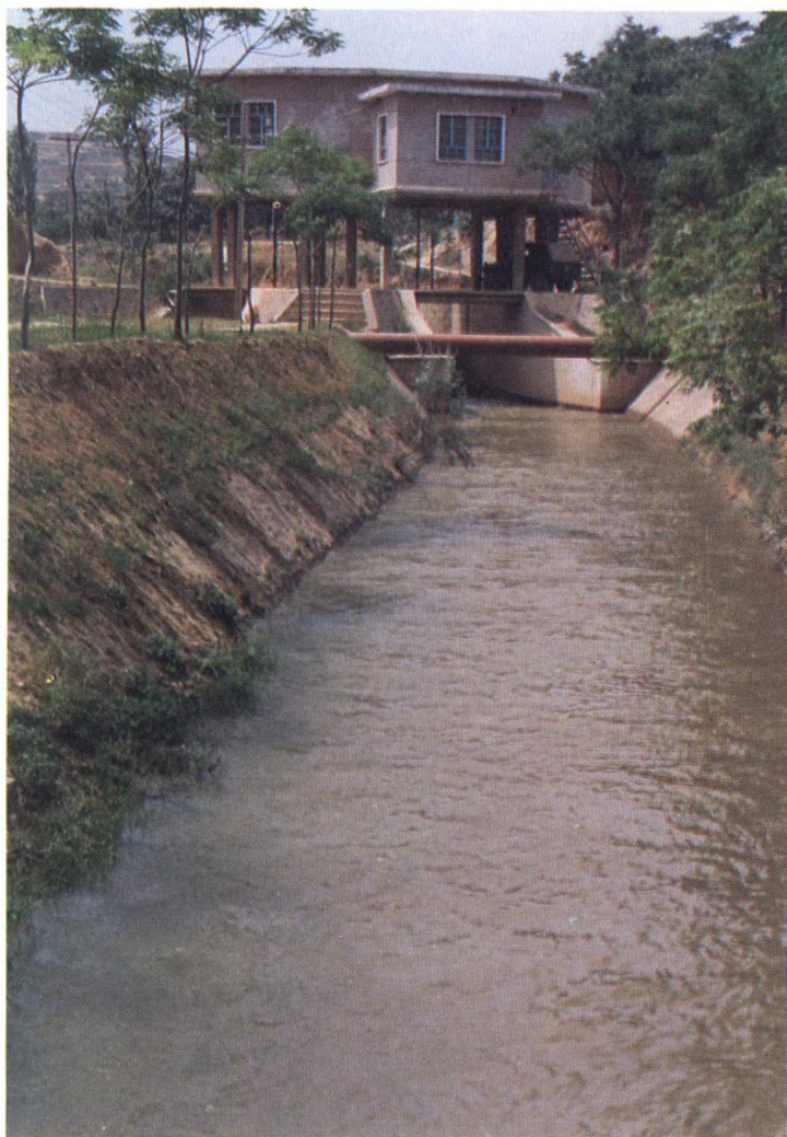
洛惠渠分水闸
