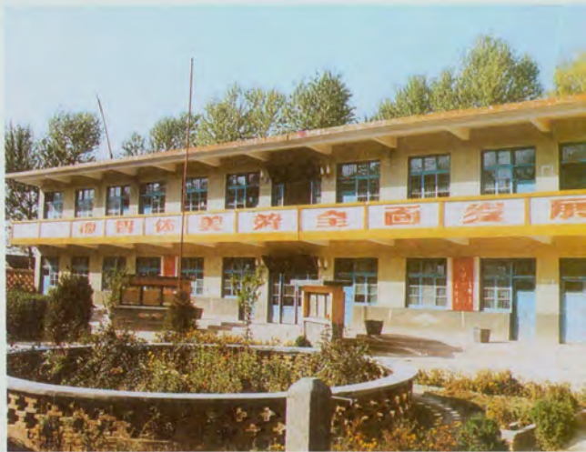
马峰峪口小学教学楼
