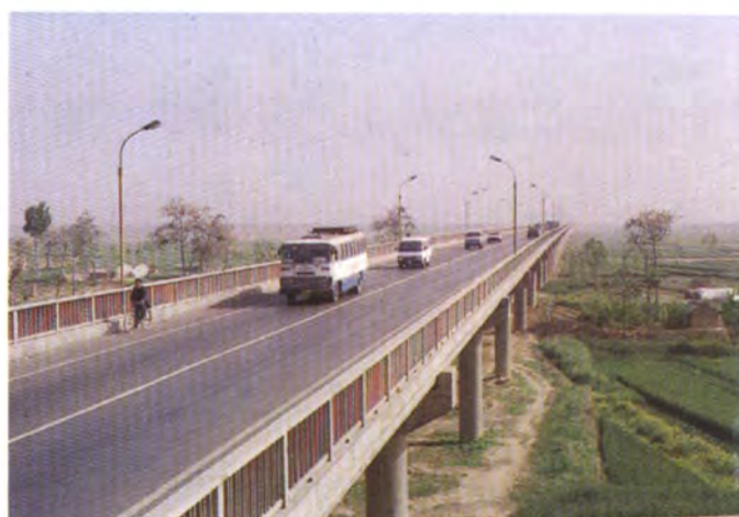
渭南沙王渭河公路大桥
