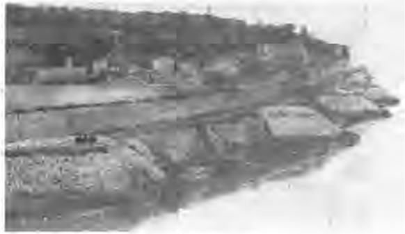
梁村塬险工段坝垛
