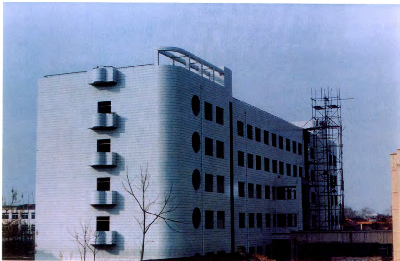
正在建设中的县医院病房楼
