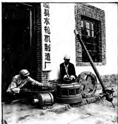
1957年县水轮机制造厂的工人正在组装木制水轮发电机。
