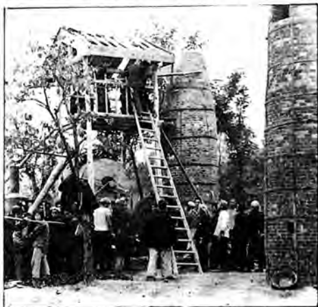
1958年大炼钢铁，各公社各村建土高炉。这是张马村正在修建的土高炉。
