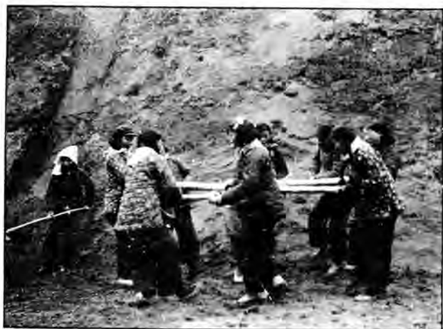
1959 年 11 月 28 日寒气袭人，哑柏公社翠峰管区的妇女社员孙凤玲等 8 人，在水库工地打石夯。
