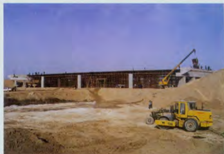
建设中的西(安)——阎(良)高速公路立交桥
