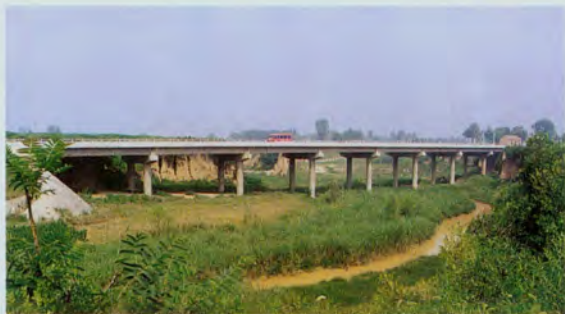
新(丰)——阎(良)公路清河桥
