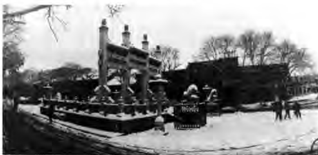
北院门街北口石碑楼
