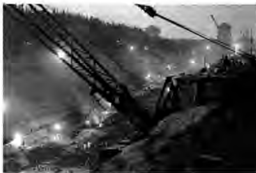
环城建设工地正在施工
