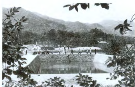
联合国资助兴建的临潼鱼池
