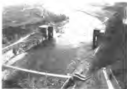
户县沔惠渠渠首
