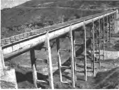
蓝田引岱工程日岩沟渡槽
