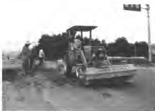
机械化整治路面病害
