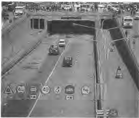
环城北路隧道
