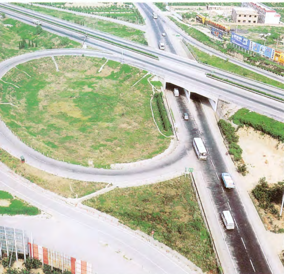
西临高速公路 人口处立交桥
