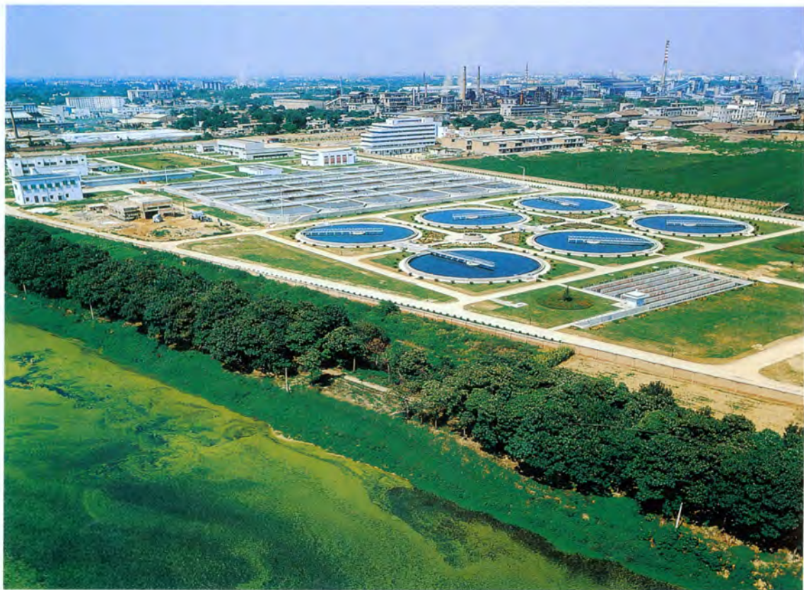
北石桥污水厂（1997年）
