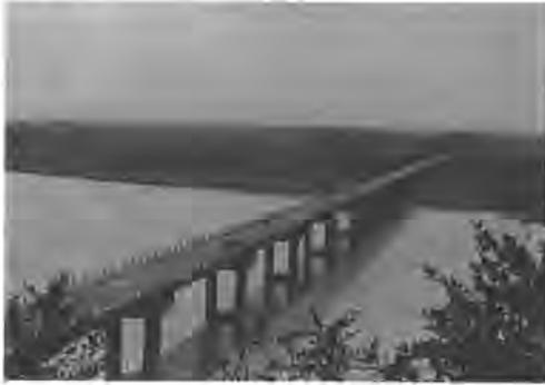
耿镇渭河大桥
