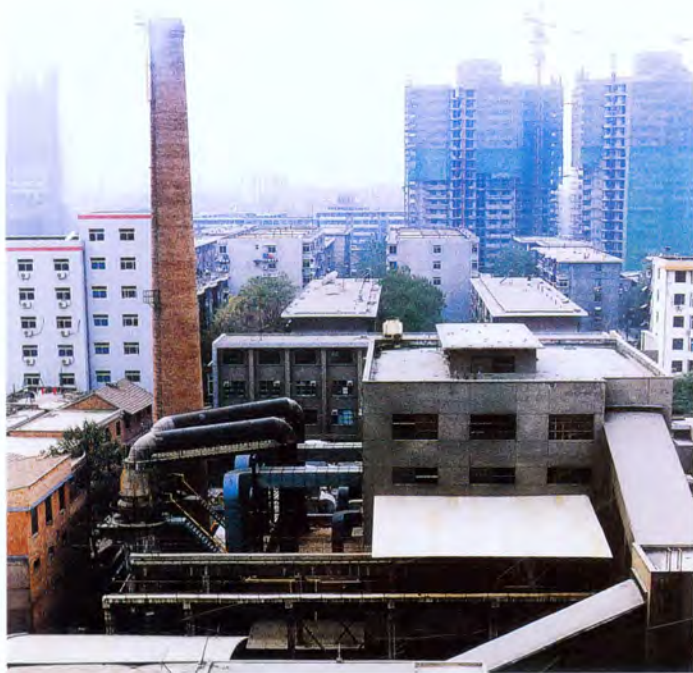
南大街供热站
