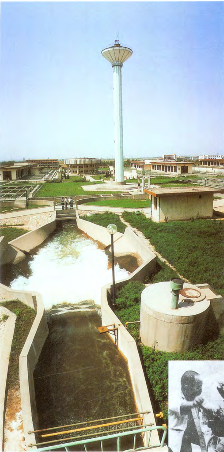
曲江净水厂进水口
