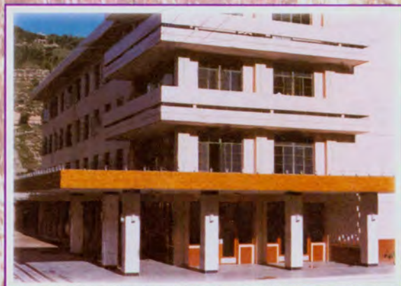
县医院住院部大楼
