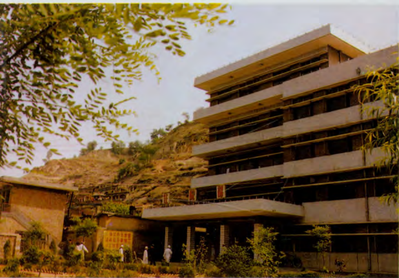
志丹县人民医院住院部
